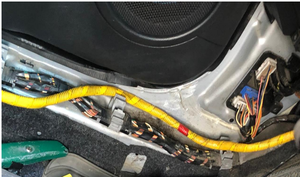
Figura 10 Desmontaje de Plástico del Vehículo
