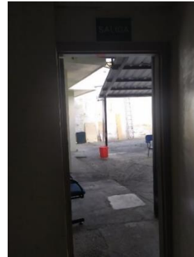
Imagen 10. Salida de emergencia - Centro de Salud N°1.
