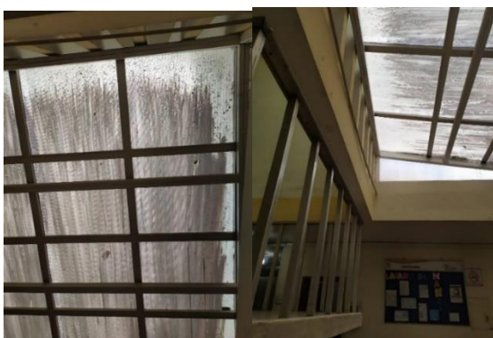
Imagen 27. Disposición de cubierta - Centro de Salud N°3.
