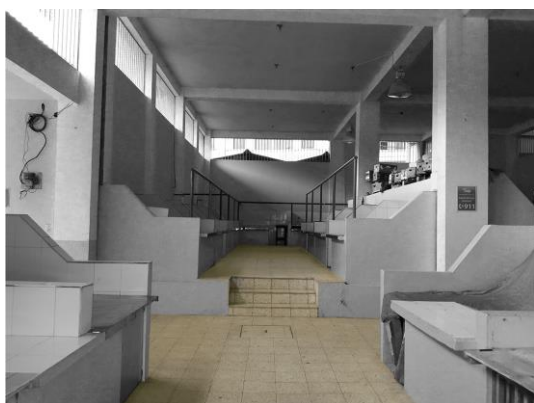
Imagen 72. Circulación horizontal, parte interna
