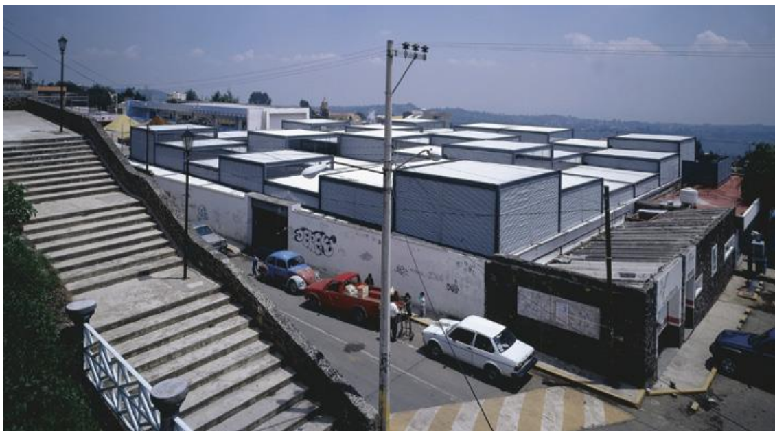
Imagen 27. Vista de cubiertas del mercado San Pablo Oztotepec
