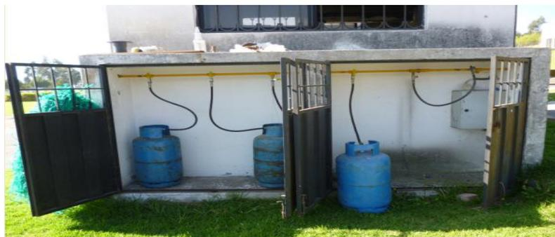
Mínimo de tanques de gas requeridos para el funcionamiento del incinerador de la Universidad Internacional del Ecuador
