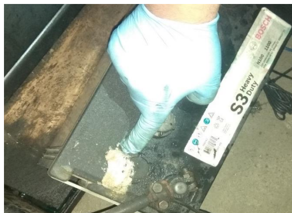
Figura 73. Presencia de sulfato en la carcasa de la batería. (Peso, 2018)
