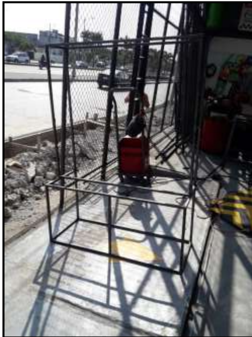
Figura 4.2 Armado de la estructura
