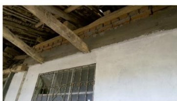
TAPIAL REEMPLAZADO POR MAMPOSTERIA DE LADRILLO
