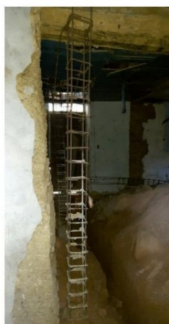
DERROCAMIENTO DE MURO DE TAPIAL
