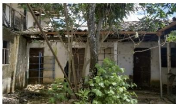
MUROS DE ADOBE SON REEMPLAZADOS POR MAMPOSTERÍA DE LADRILLO
