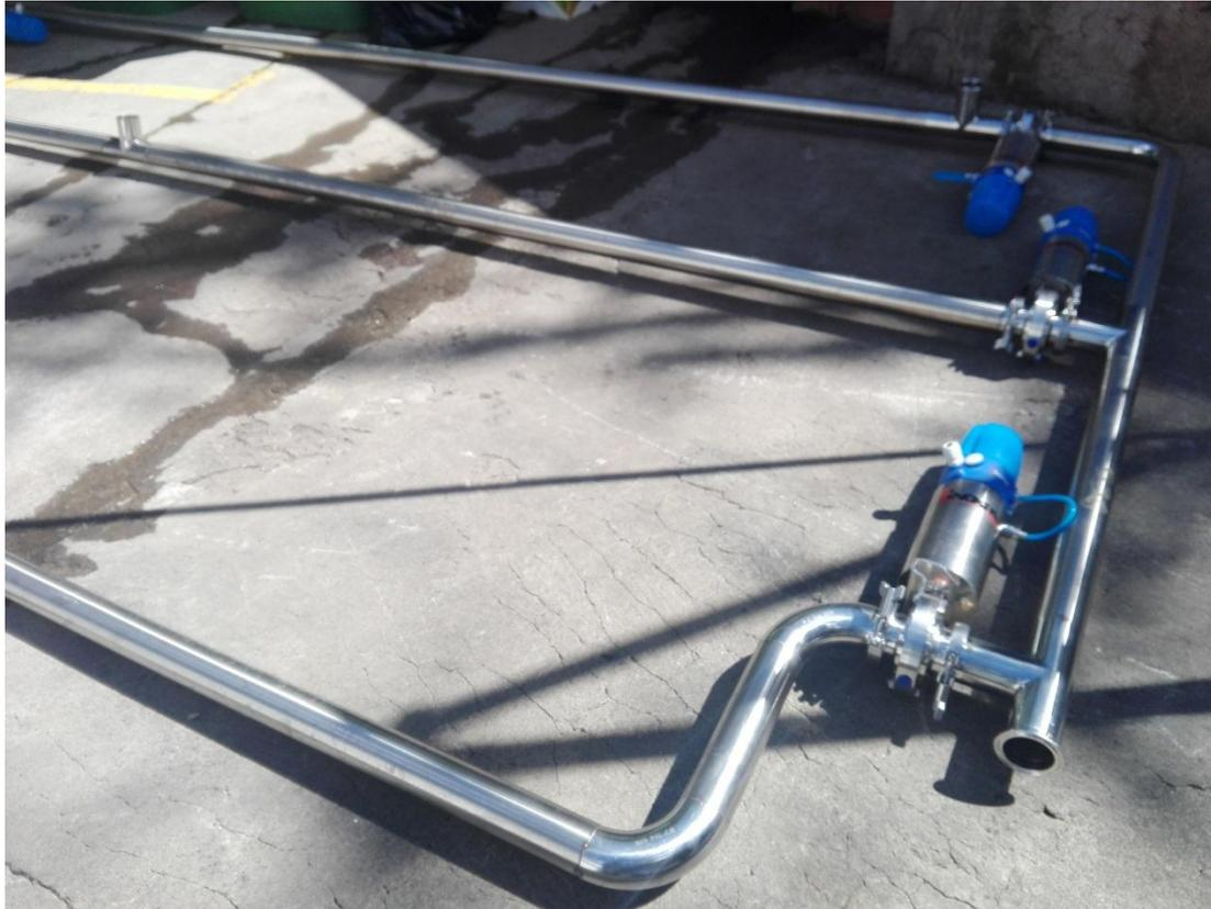
**Figura 70.** Armado de tramos de tuberías con válvulas de control
