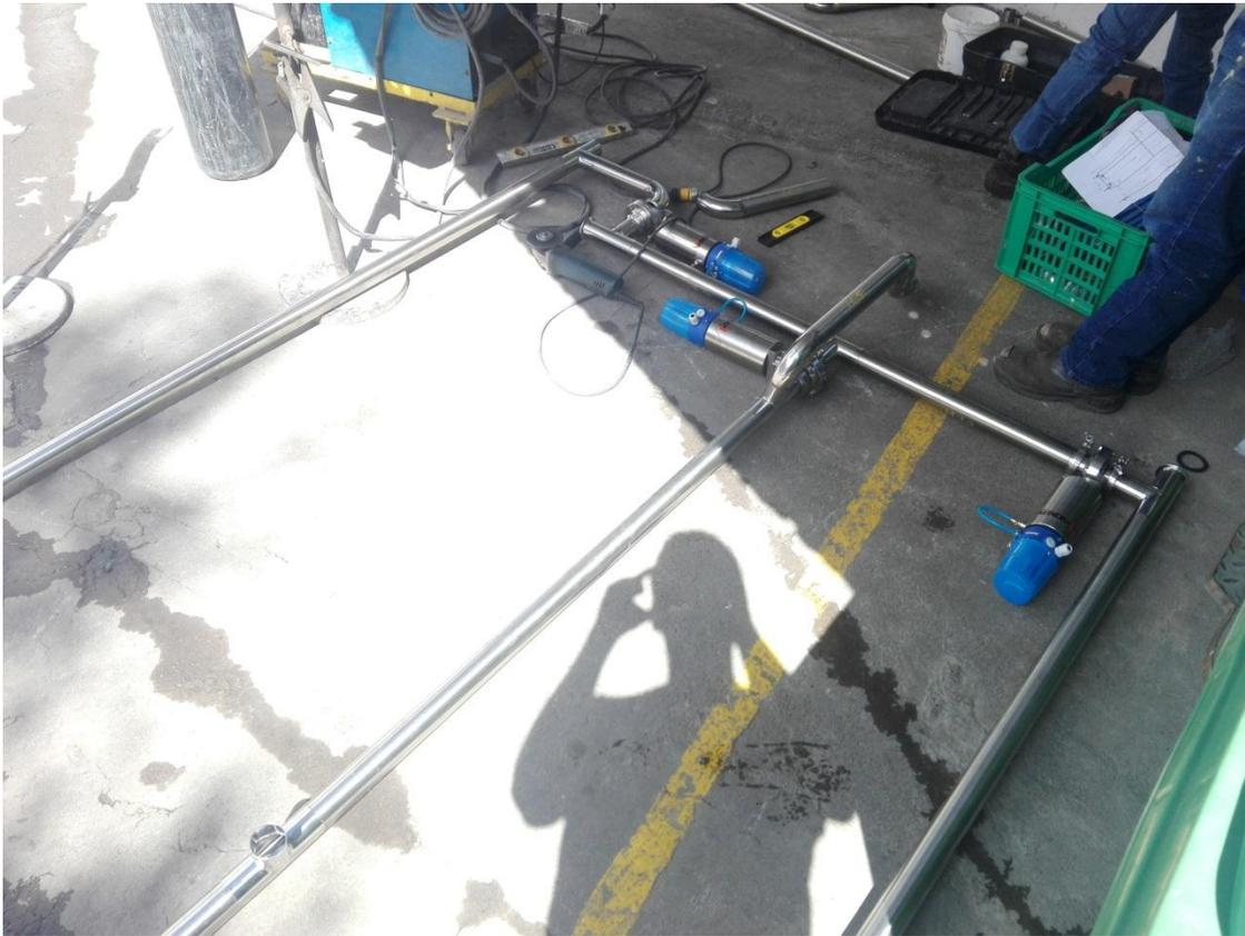
**Figura 71.** Armado de tramos de tuberías con válvulas de control
