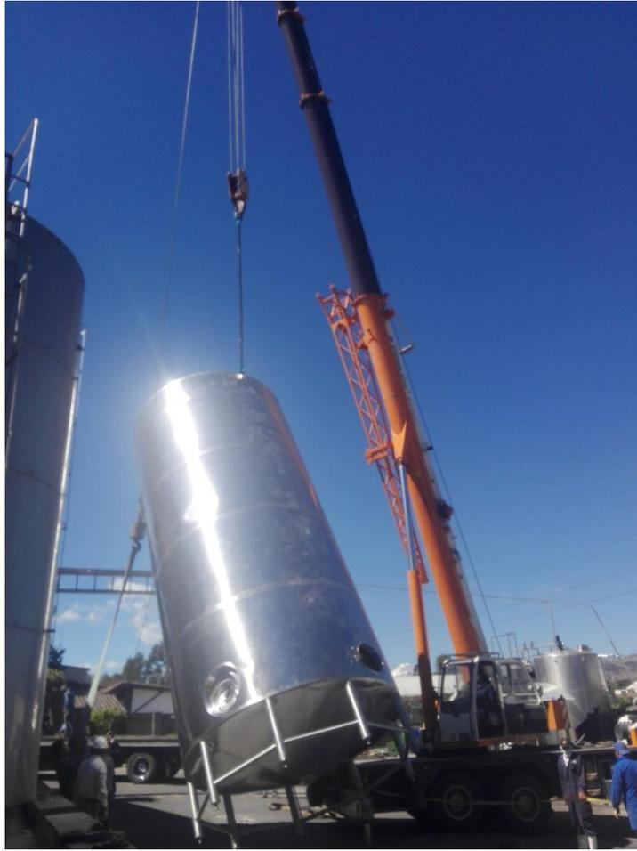
**Figura 77.** Levantamiento del silo de 50000 L para su ubicación
