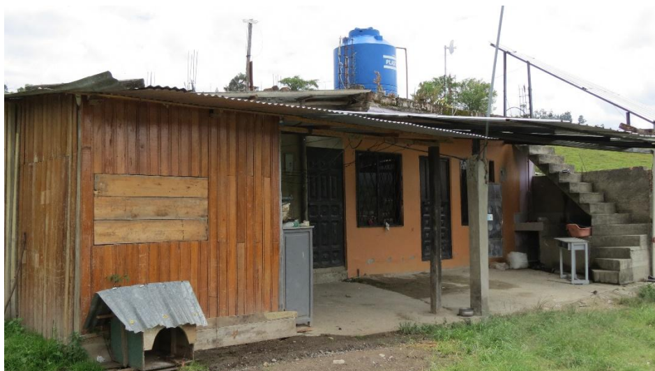
Ilustración 55. Modificación en la edificación
