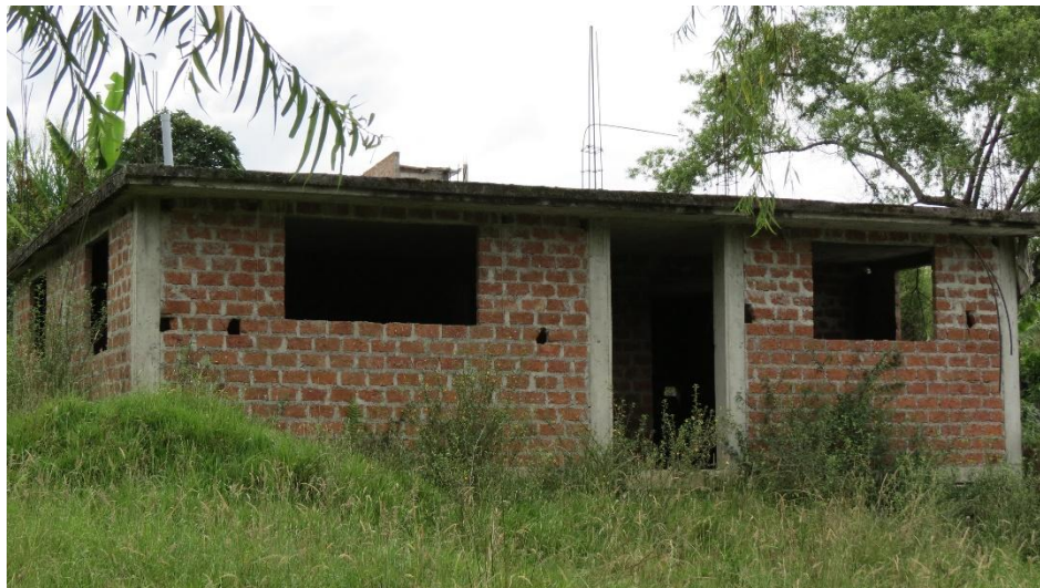
Ilustración 46. Vivienda en construcción
