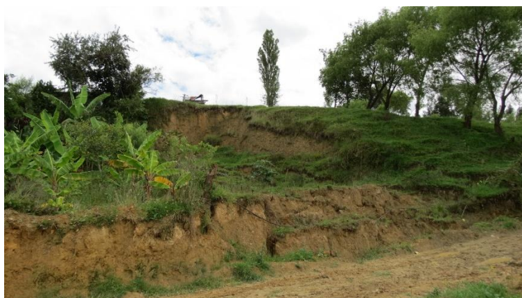
Ilustración 34. Predios con deslizamiento de tierra
