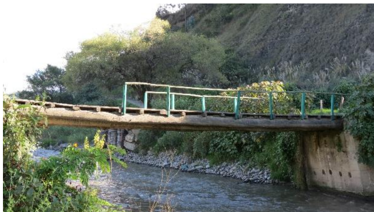
Ilustración 16. Puente de ingreso vehicular al barrio El Castillo
