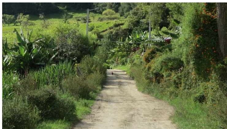
Ilustración 25. Zanjas sin mantenimiento
