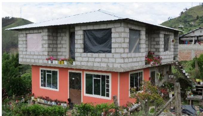
Ilustración 57. Edificación en estado regular
