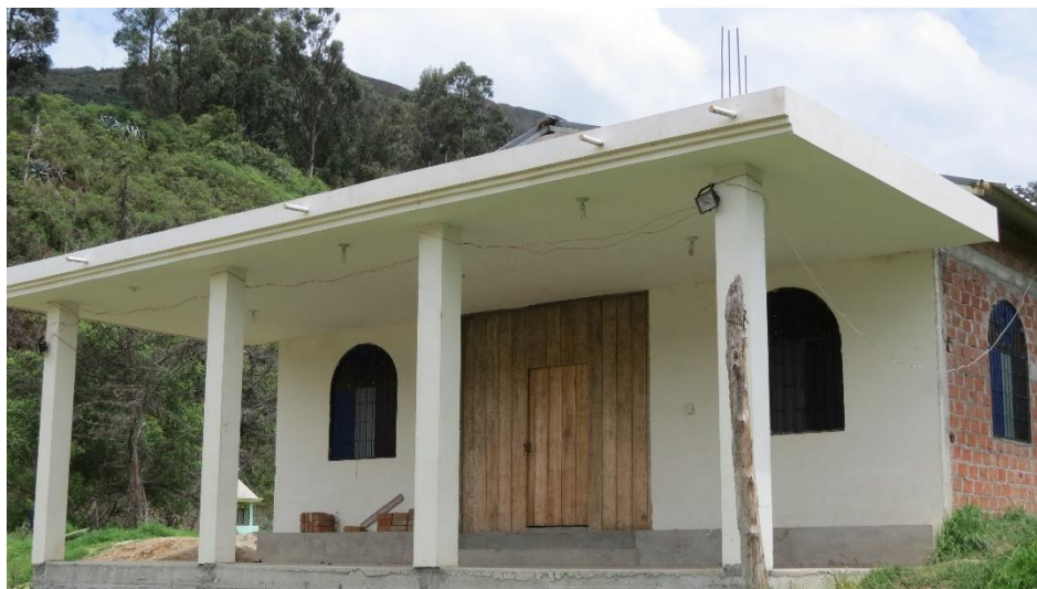
Ilustración 47. Iglesia en construcción
