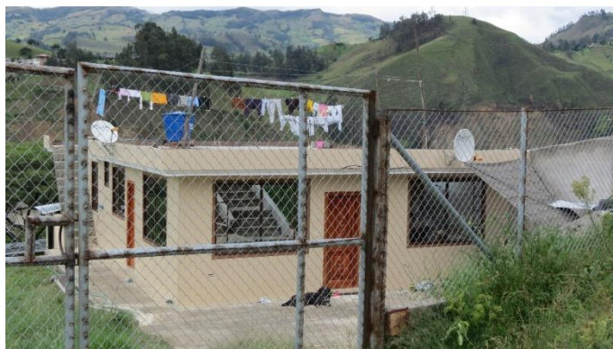
Ilustración 56. Edificación en buen estado
