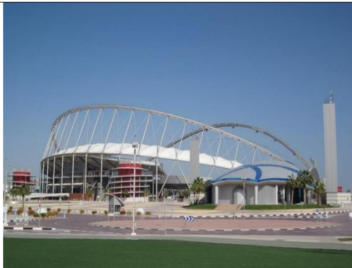
Imagen 32: Vista de estructura metálica
