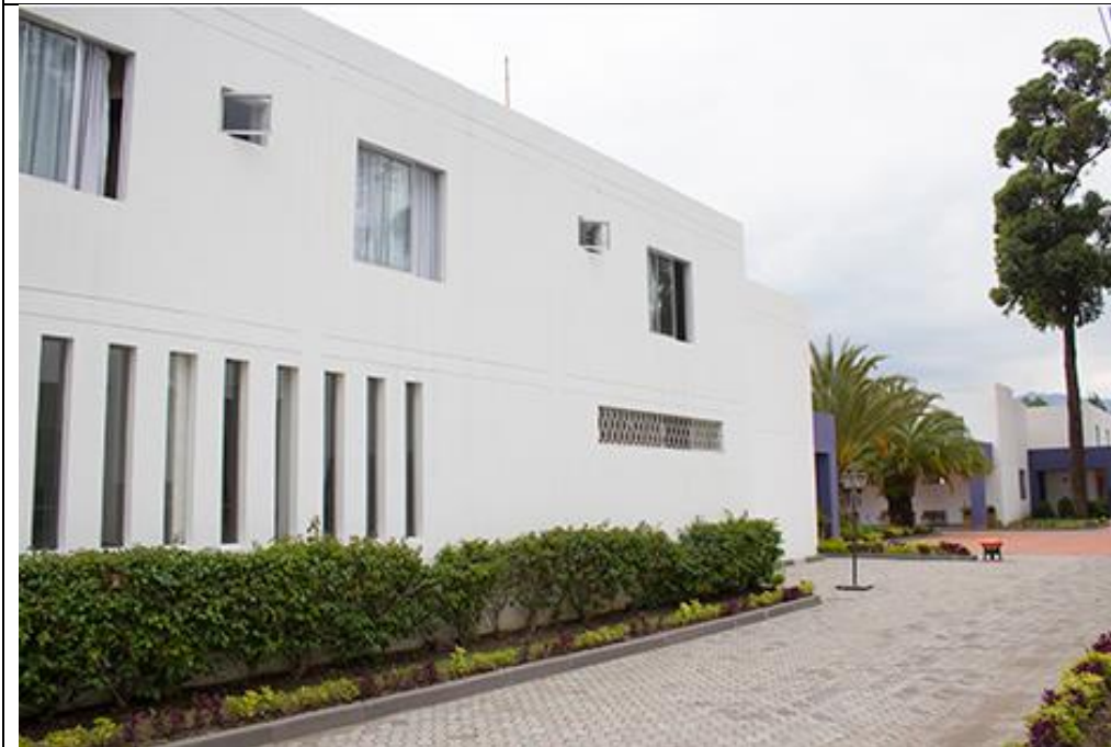
Imagen 15: Vista externa instalaciones - Sede Independiente del Valle
