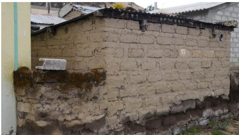
Imagen 3: Vivienda de adobe en Zumbahua
