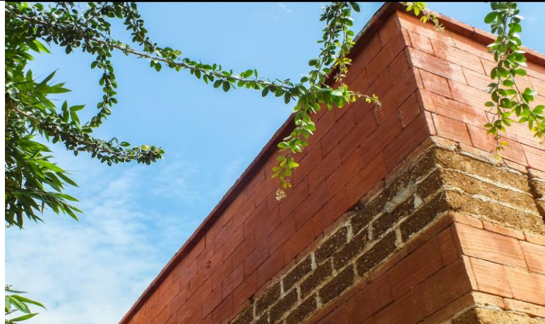
Imagen 26: Materialidad en las fachadas
