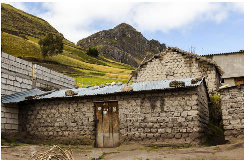
Imagen 4: Vivienda de adobe en Zumbahua
