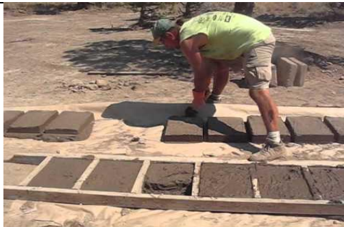
Imagen 15: Desencofrado del adobe
