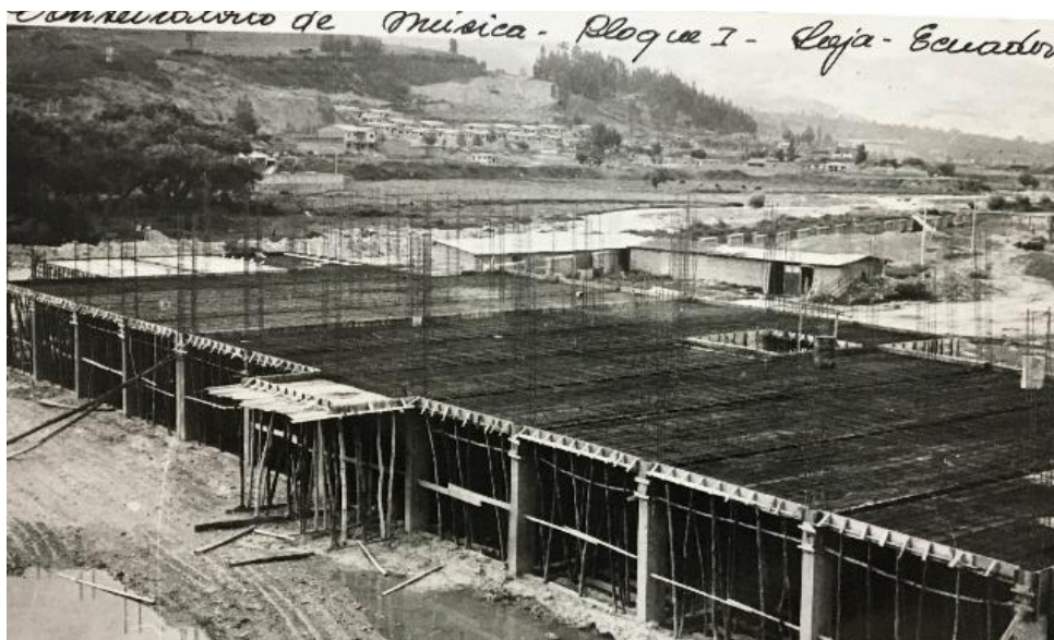
Figura 9. Construcción bloque uno
