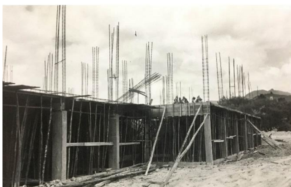
Figura 8. Construcción bloque uno
