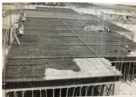
Figura 7. Construcción bloque uno
