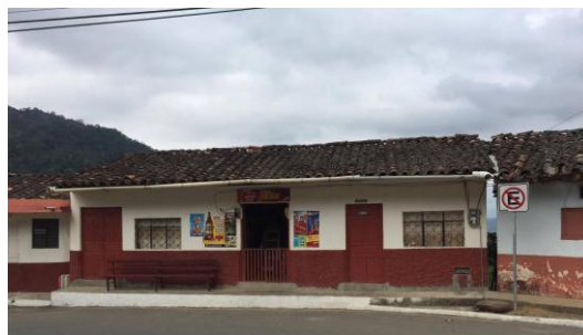
Imagen 47. Entorno arquitectónico (vivienda de adobe)
