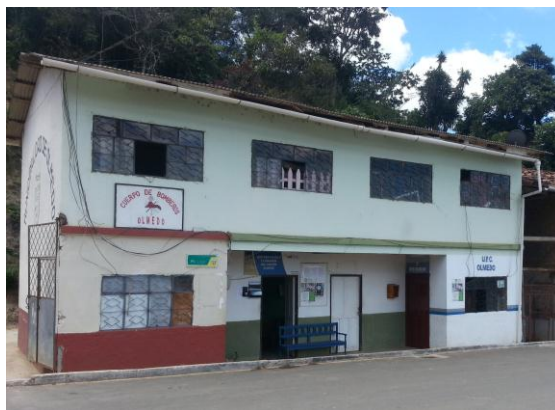
Imagen 36. Fachada de la edificación
