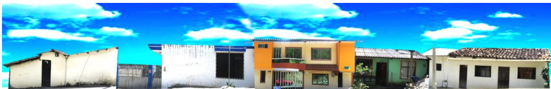
Imagen 49. Perfil urbano de la Av. Occidental
