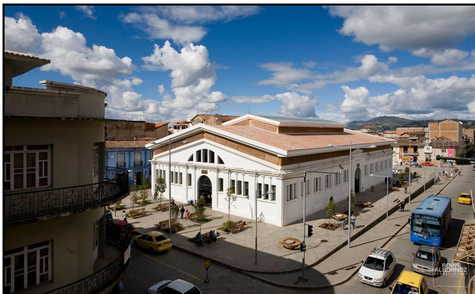
Imagen 12. Vista externa del Mercado 9 de Octubre
