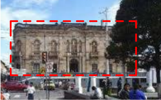
Figura 2.4: Construcción en Adobe / Cayambe
