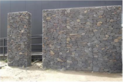
DETALLE MURO DE GAVIÓN
