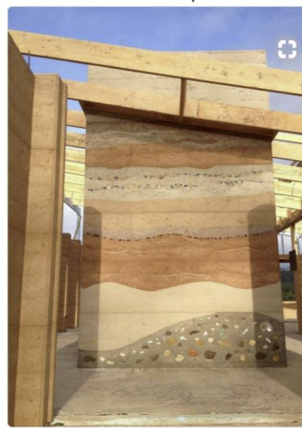
MURO DE ADOBE Y TAPIAL REFERENTE
