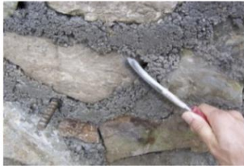
JUNTA CON MORTERO
