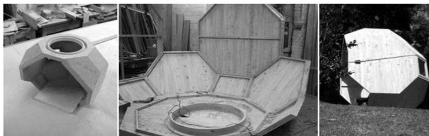
Figura 15. Construcción. Fuente: Manuel Villa, 2009, Habitable Polyhedron Bogota Columbia, The Many Faces of a Polyhedron,
