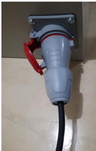
Figura 4.38: Conector Legrand tripolar con tierra
