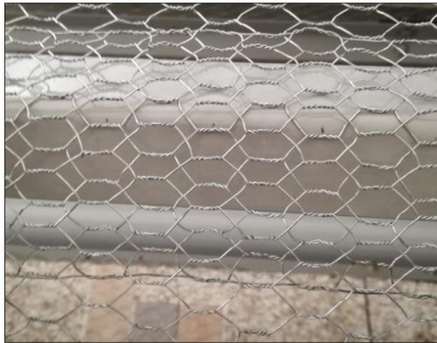
Figura 4.23: Punto de unión de las dos mallas del hexágono
