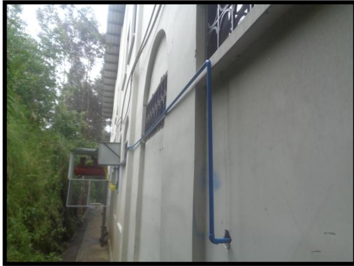
**Figura 5.7** Instalación de las líneas de aire
