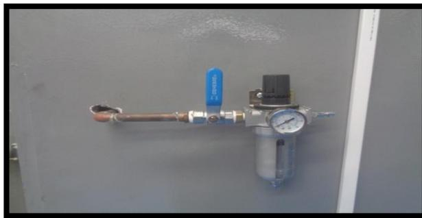
**Figura 5.10** Instalación de la llave de paso y filtro trampa de agua con acople y manómetro de presión
