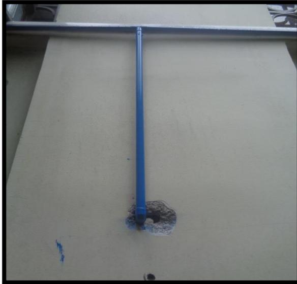
**Foto 5.8** Instalación de líneas con sus respectiva T y codo de cobre soldados
