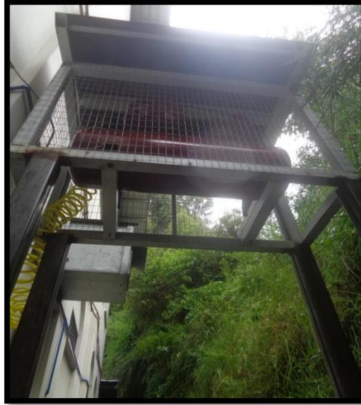
**Figura 5.14** Fabricación e instalación de la estructura soportante para el compresor
