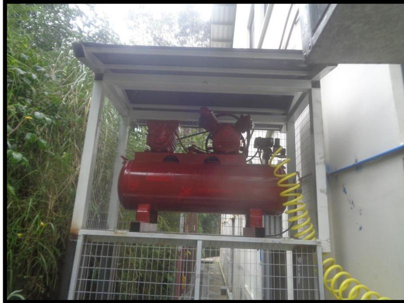
**Figura 5.13** Colocación del compresor y su tanque de reserva dentro de la estructura
