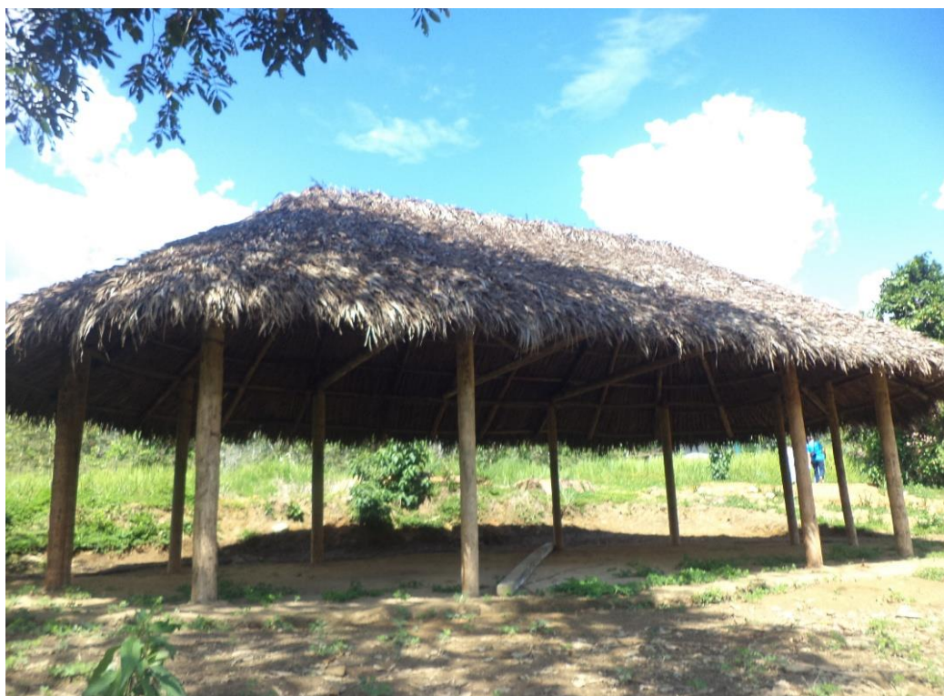
Fotografía 17/ Vivienda Shuar en construcción en la comunidad Kiim
