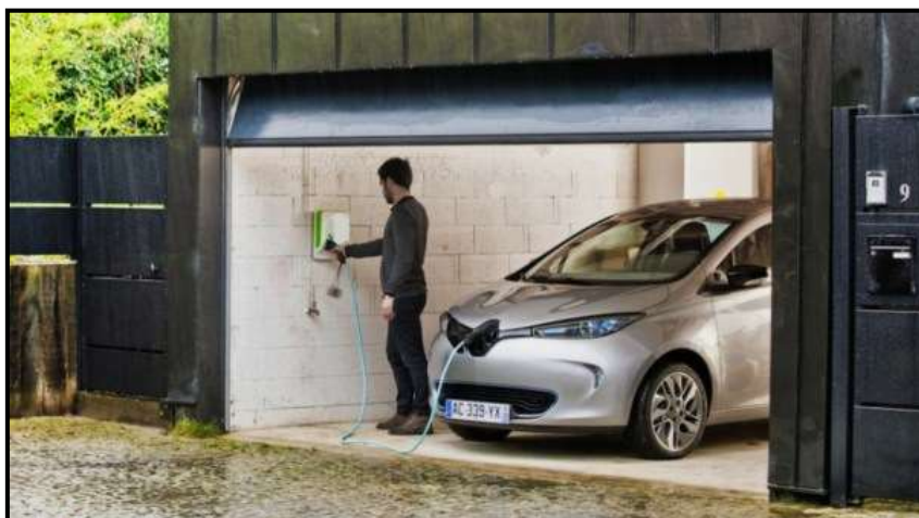
Figura 15. Estación de recarga en parqueo unifamiliar Fuente: Rivera, N (2016). Los hogares de la UE tendrán puntos de recarga para vehículos eléctricos a partir de 2019. Innovación Motor Editado por: Luis Fabre
