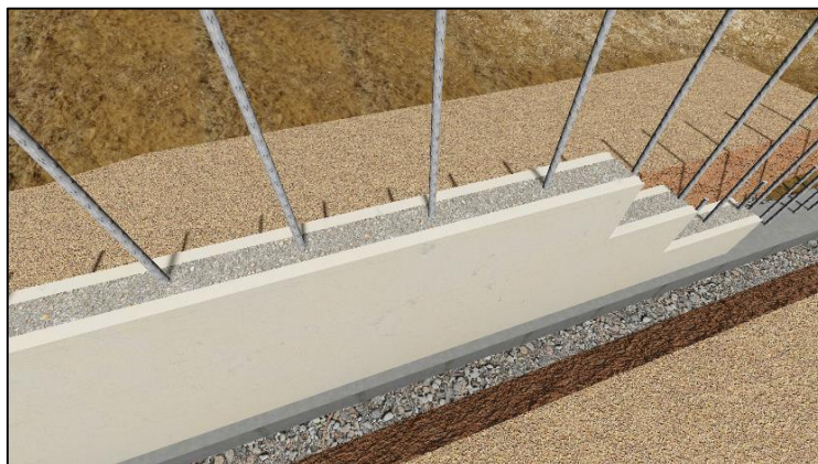
Ilustración 30: Colocación de la primera hilada
