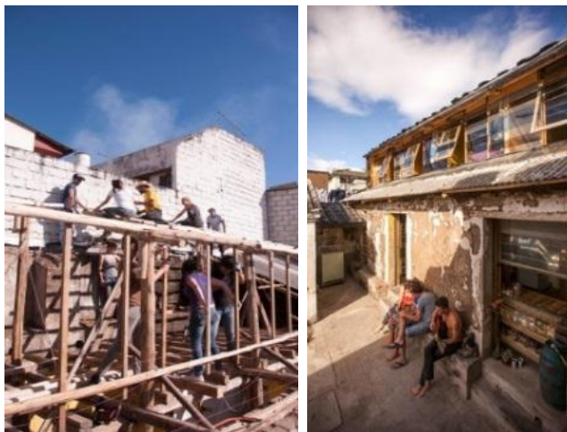
Fuente: Al Borde, 2014. Casa en Construcción
