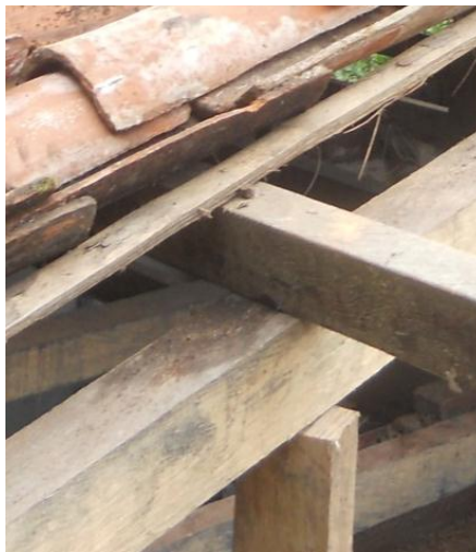
Imagen 51. Detalle de solapado de madera unido con varilla de acero # 10
