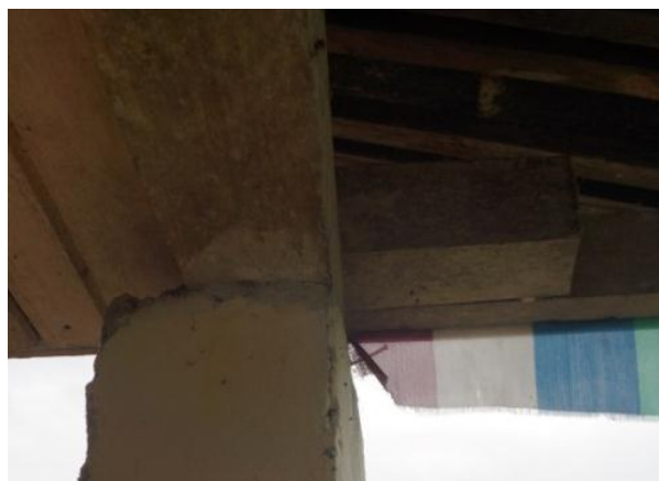
Imagen 50. Vigas soleras de la construcción actual
