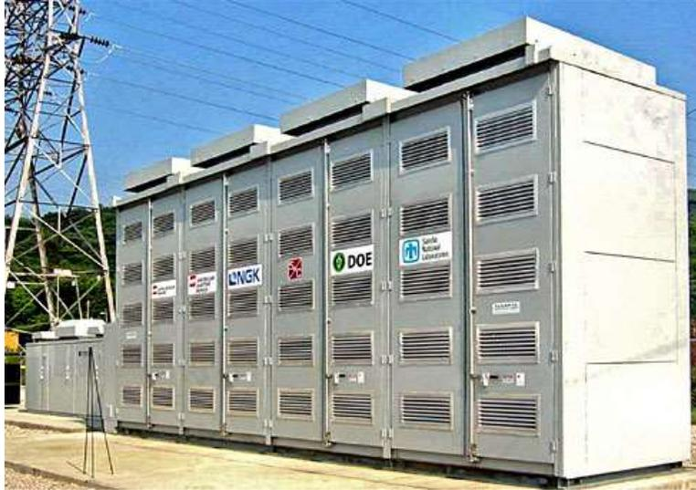
**Figura 1.14:** Batería Sodio-Azufre
