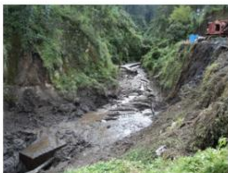
Retiro y transportación de lodos hacia un stock fecha: 07 de marzo de 2011
