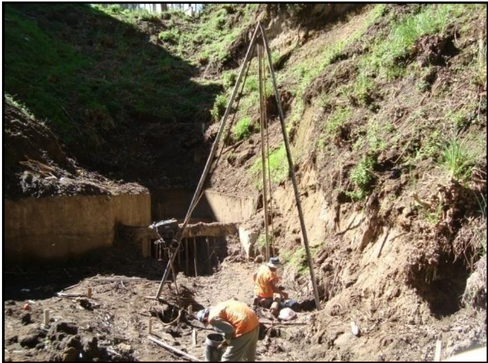
Foto 41: Implantación de equipos para realizar perforación.
