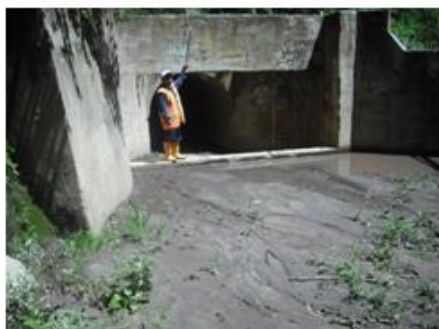
Ingreso a túnel de trasvase fecha: 22 de octubre de 2010
