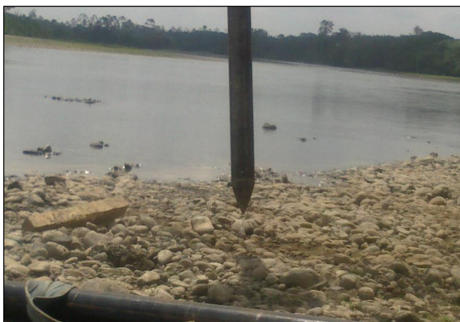
Foto 43: Punta de pilote metálico. Fuente: Proyecto Pantallas Río Blanco KP 378 OCP
