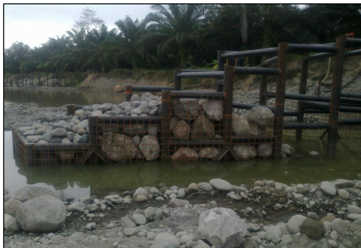
Foto 45: Conformación de muro tipo espigón. Fuente: Proyecto Pantallas Río Blanco KP 378 OCP
