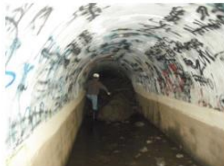
Interior del túnel de trasvase fecha: 22 de octubre de 2010
