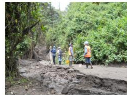
Topografía realizada en zona del pozo de captación fecha: 01 de julio de 2011
