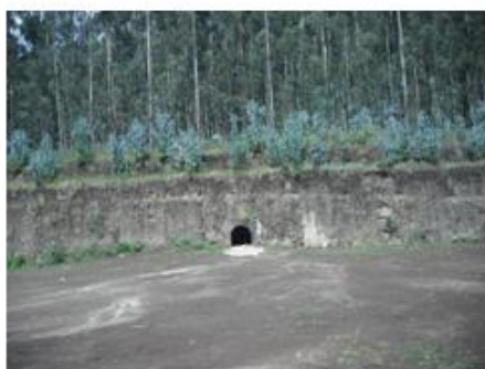
Salida de túnel de trasvase fecha: 22 de octubre de 2010
