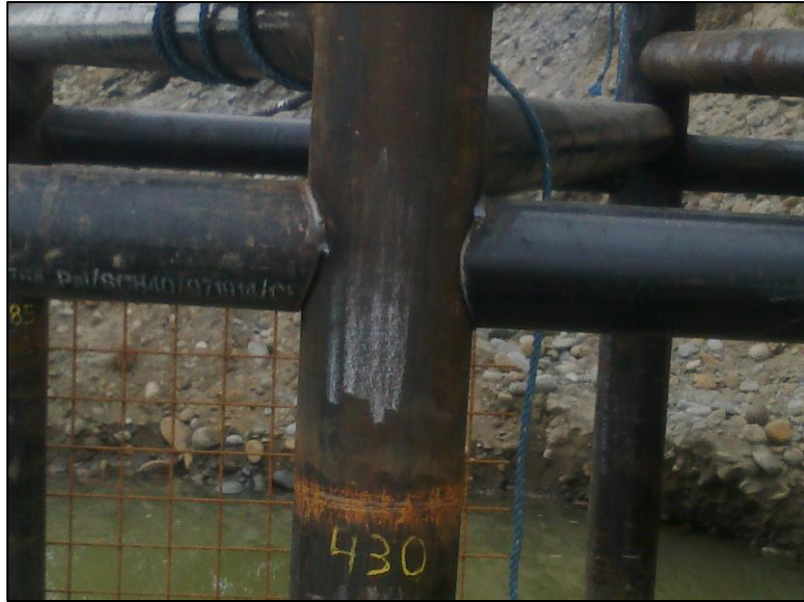
Foto 44: Cortes tipo boca de pescado para unión. Fuente: Proyecto Pantallas Río Blanco KP 378 OCP
