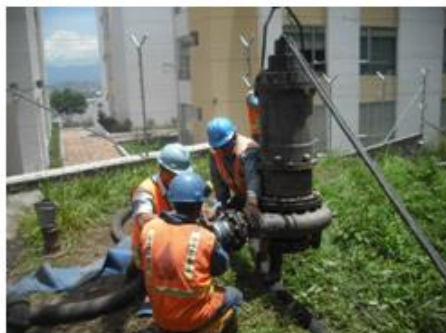
Instalación de bomba sumergible para evacuar lodos fecha: 10 de marzo de 2011
