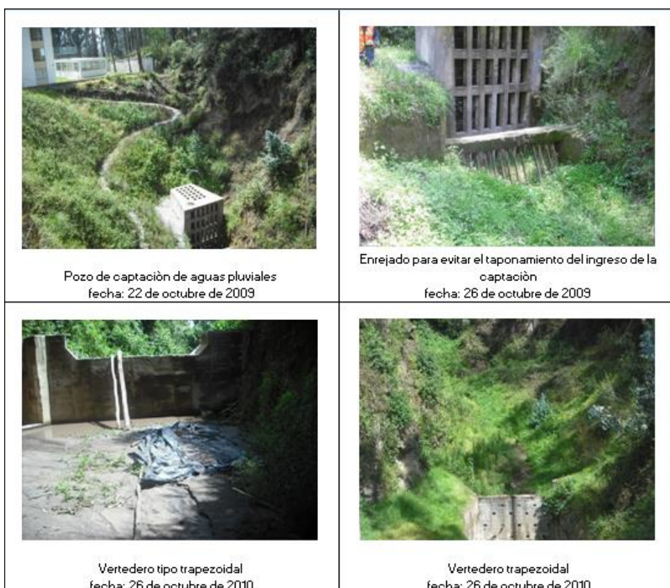
Foto 11, 12, 13, 14: Obras en la Quebrada Caicedo Fuente: EPMAPS
