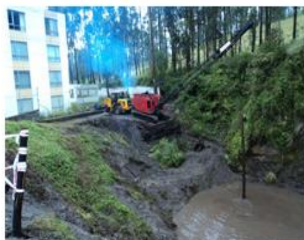
Grúa de poleas realizando localización y rotura de losa de pozo de captación fecha: 06 de marzo de 2011
