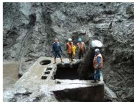
Evacuación de material alojado al interior del pozo de captación fecha: 13 de marzo de 2011
