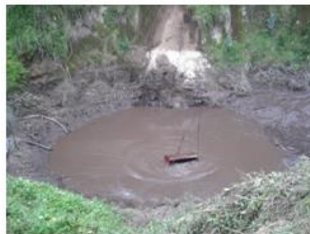
Dragado de lodos con la utilización de una grúa de poleas fecha: 06 de marzo de 2011
