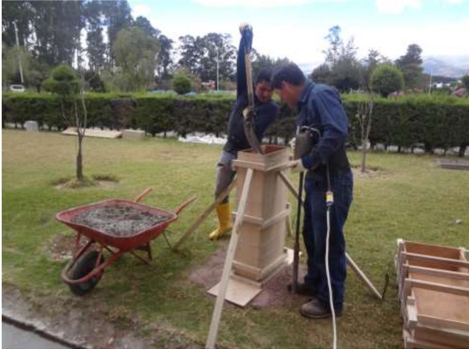
**Figura 14 Colocación del hormigón**
