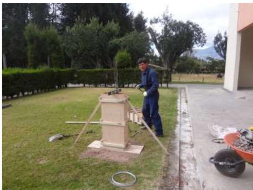
**Figura 9 Nivelación y apuntalamiento de encofrados**
