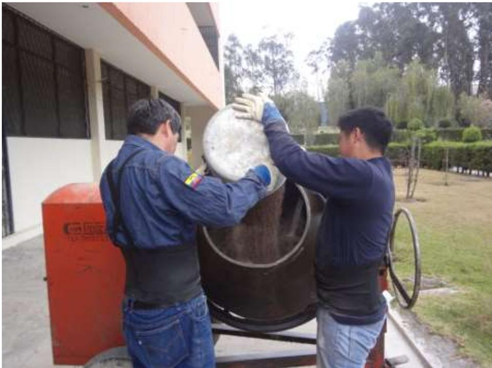
**Figura 13 Colocación de los agregados en la concreteira**
