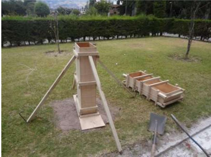
**Figura 10 Encofrados listos para fundir**
