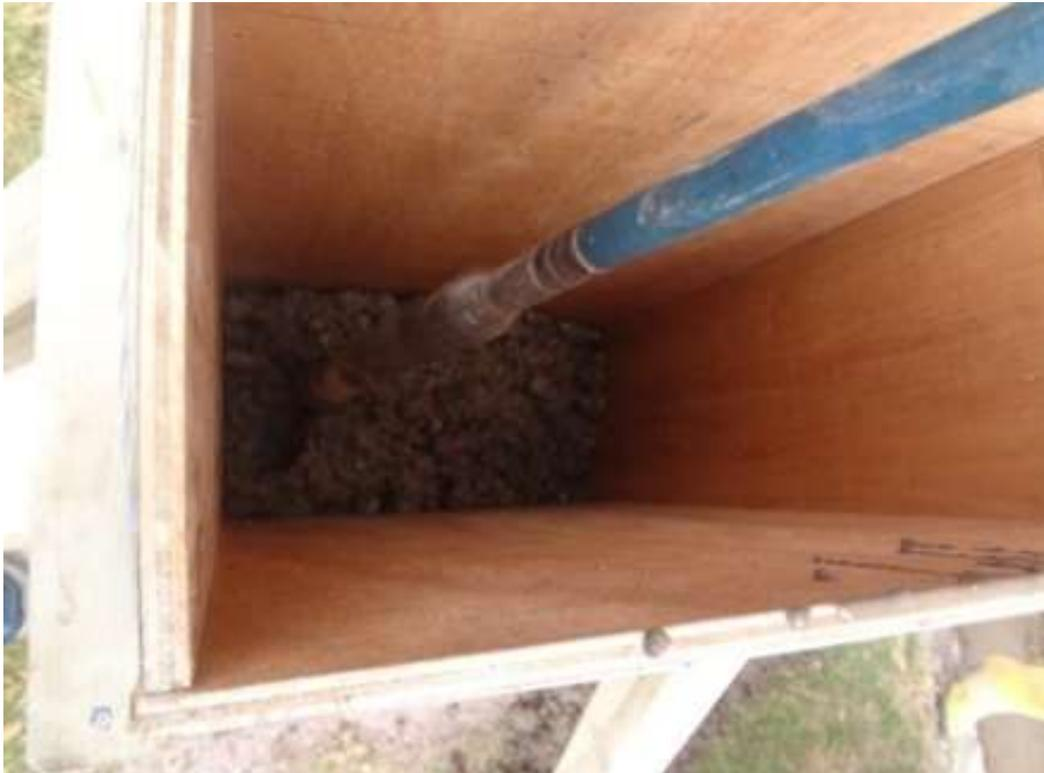
**Figura 15 Vibrado del hormigón en la columna**
