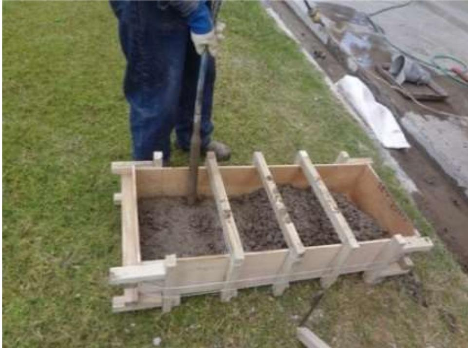
**Figura 16 Vibrado del hormigón en la viga**
