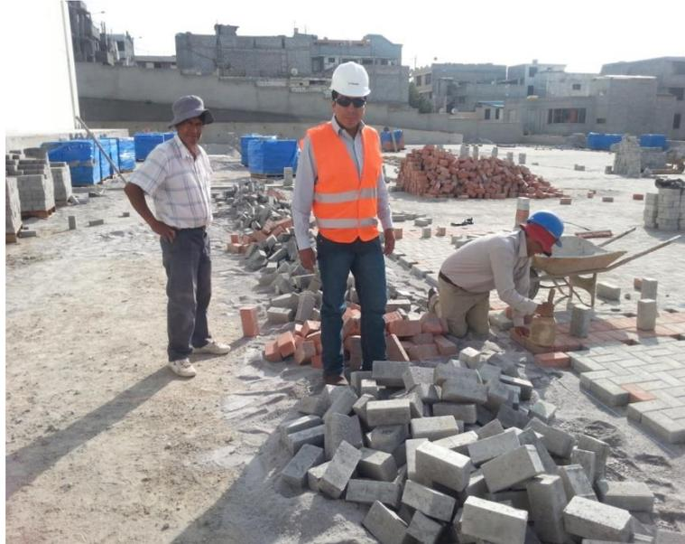
**Figura. 2.9. Construcción Pavimentos Articulados**
