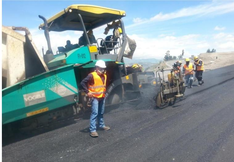
**Figura.2.6. Construcción Pavimentos Flexibles**
