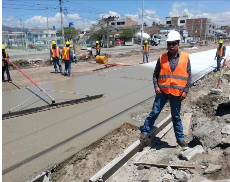
**Figura.2.8. Construcción Pavimentos Rígidos**
