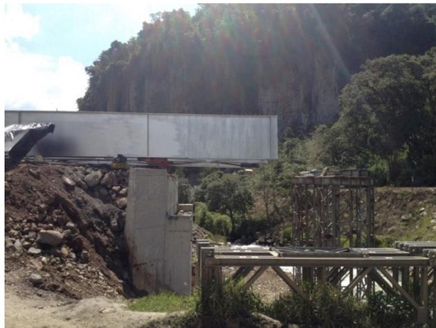
DIA 46. Lanzamiento de 5 metros (Total lanzado 5m.)
