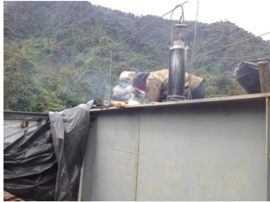
DIA 61-65. Armado, Alineación, nivelación y soldadura de dovelas de 4 metros
