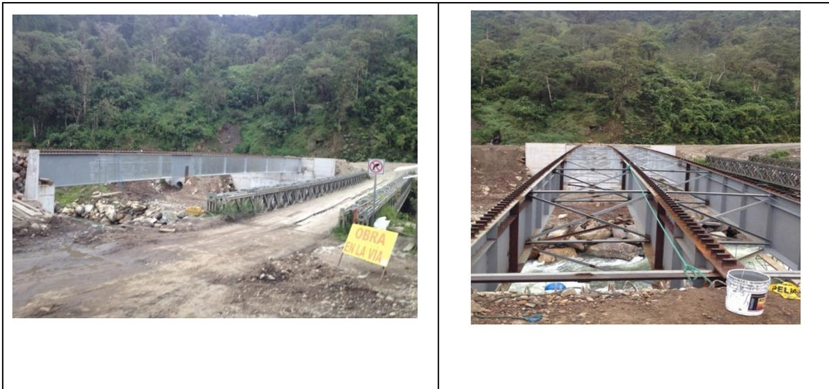
DIA 69-72. Nivelación del Puente sobre los estribos
