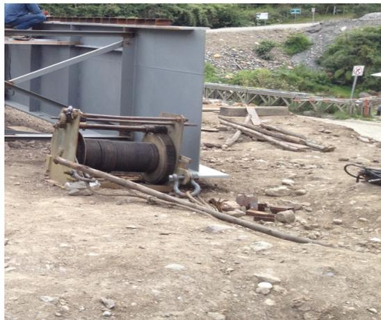
DIA 42-43. Preparación del sistema de lanzamiento
