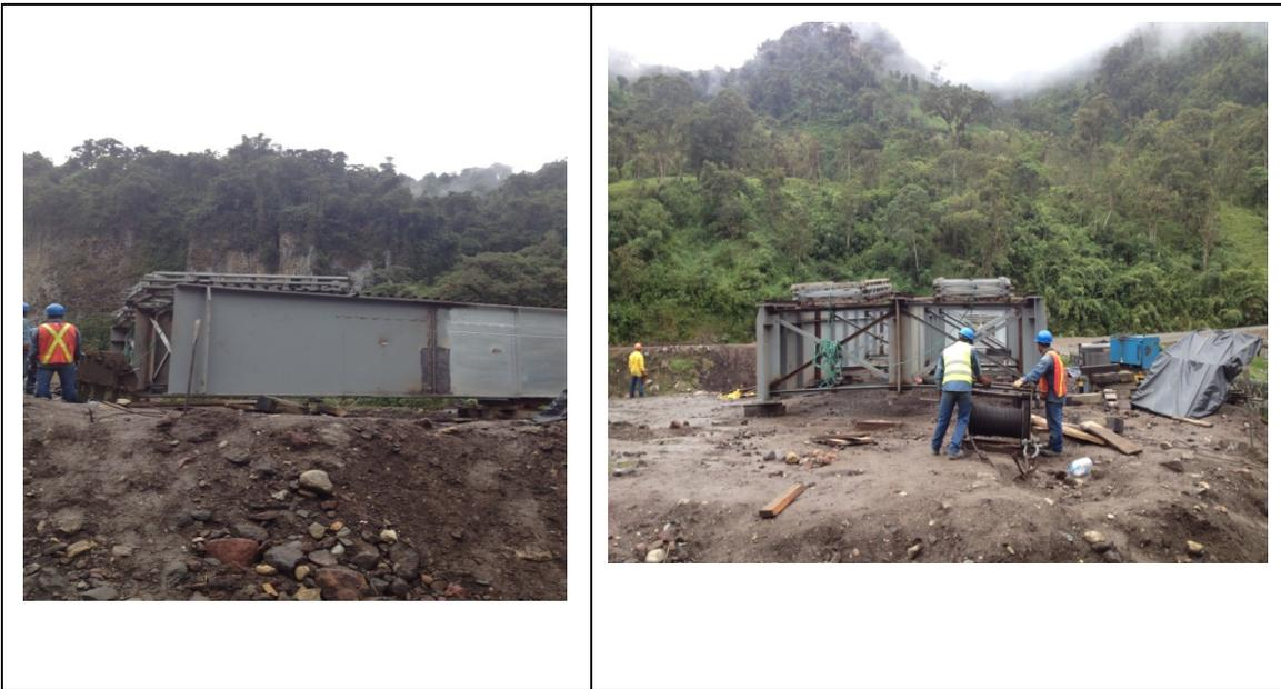
DIA 66-68. Lanzamiento Total del puente (40m.)
