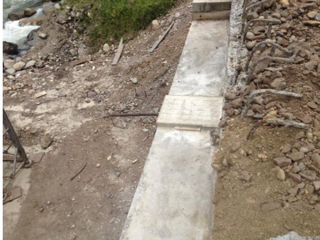
DIA 54. Fundición de apoyos de hormigón de vigas centrales
