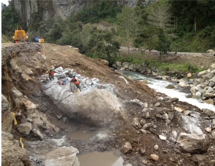
DIA 3 Excavación en Roca Estribo Izquierdo
