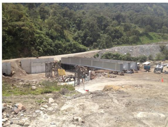
DIA 54. Lanzamiento de siguientes 6 metros (Total lanzado 10m.)
