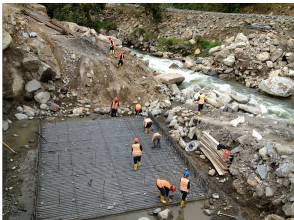
DIA 14 Replanteo Zapata Estribo Izquierdo Puente Cuyuja
