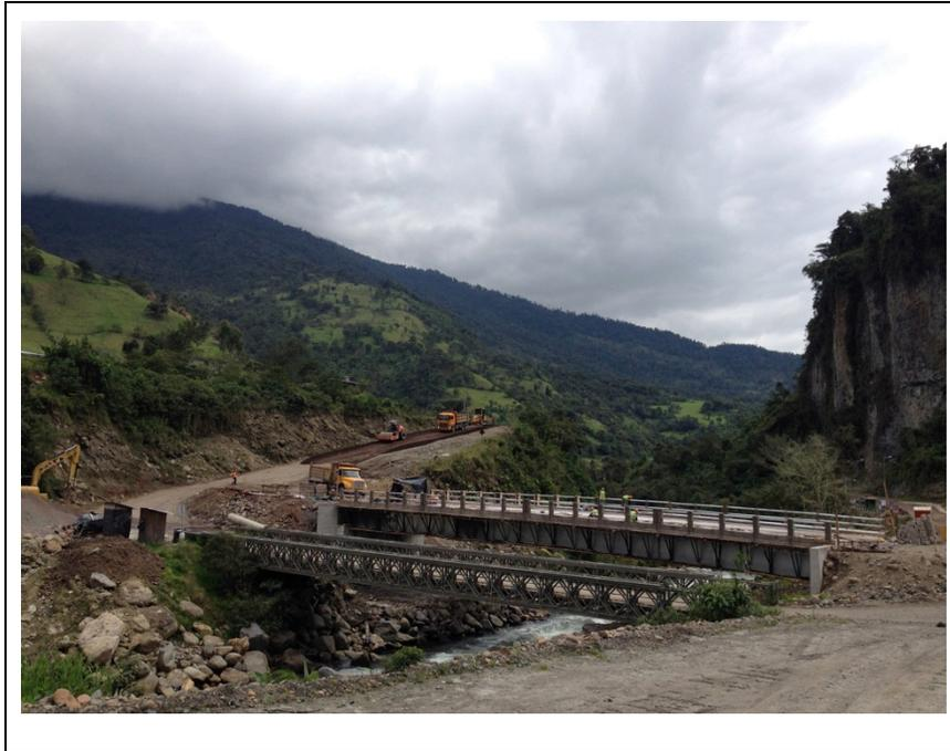
**Gráfico 4.18:** Conformación de accesos al Puente, previo a la apertura del tráfico
