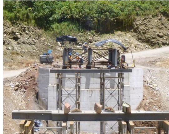
DIA 55-57. Alineación y nivelación de dovelas de 4 metros
