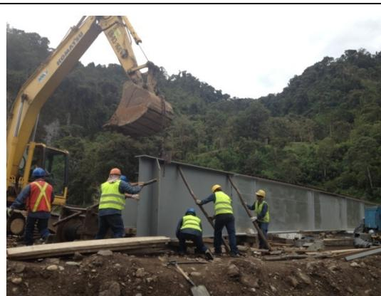
DIA 61-65. Armado, Alineación, nivelación y soldadura de dovelas de 4 metros
