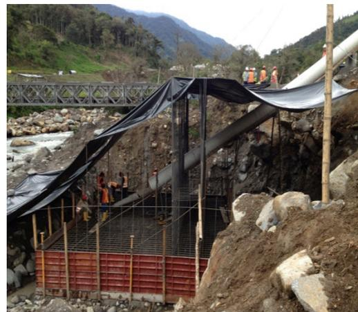
DIA 23 Armado y Fundición Zapata Estribo Izquierdo Puente Cuyuja
