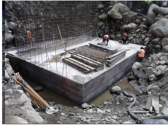
DIA 27 Armado y Fundición Zapata Estribo
