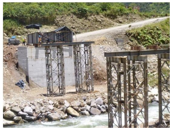
DIA 57-62. Armado, Alineación, Nivelación y soldadura de dovelas de 10 metros
