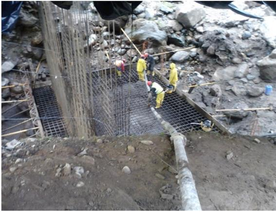
DIA 23 Armado y Fundición Zapata Estribo
