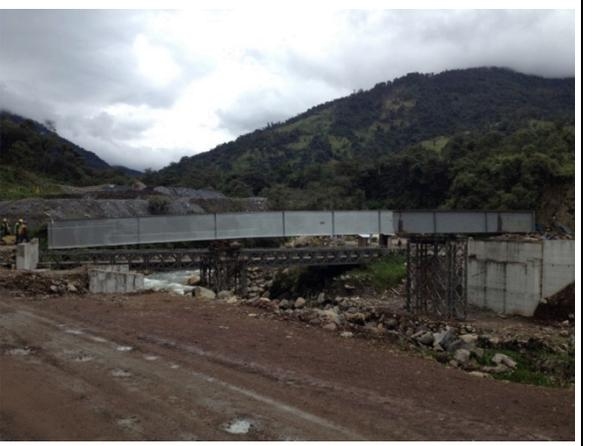
DIA 66-68. Lanzamiento Total del puente (40m.)
