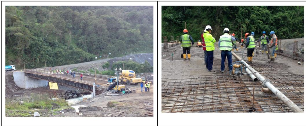
**Gráfico 4.17:** Armadura y remate, trabajo de vaciado
