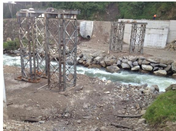
DIA 51-55. Armado de torres (obra falsa) para montaje del puente
