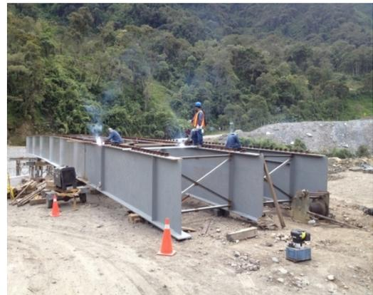
DIA 55-59. Armado, Alineación, nivelación y soldadura de vigas de 10 metros
