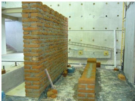
Fig. 4.4 Construcción de mampostería doble utilizando el trabe inglés.
