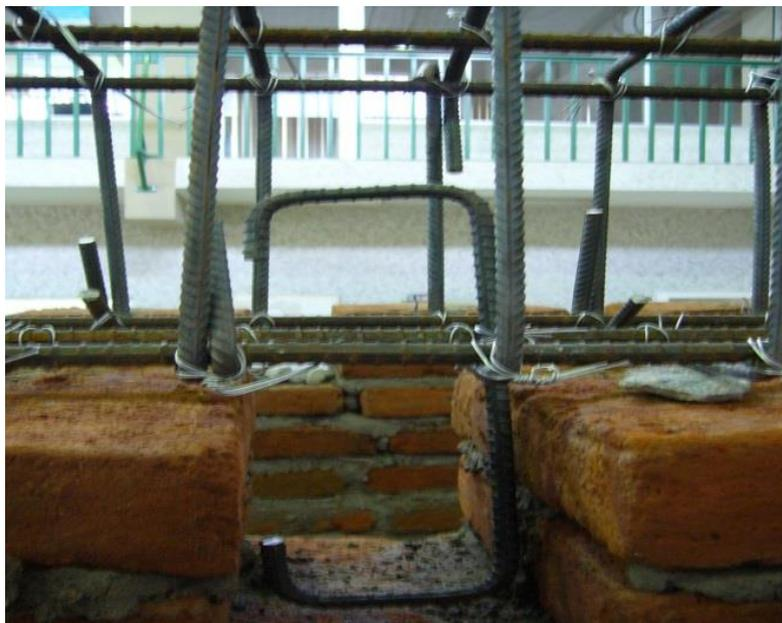
Fig. 4.6 Acero de refuerzo tipo C para anclaje viga-mampostería
