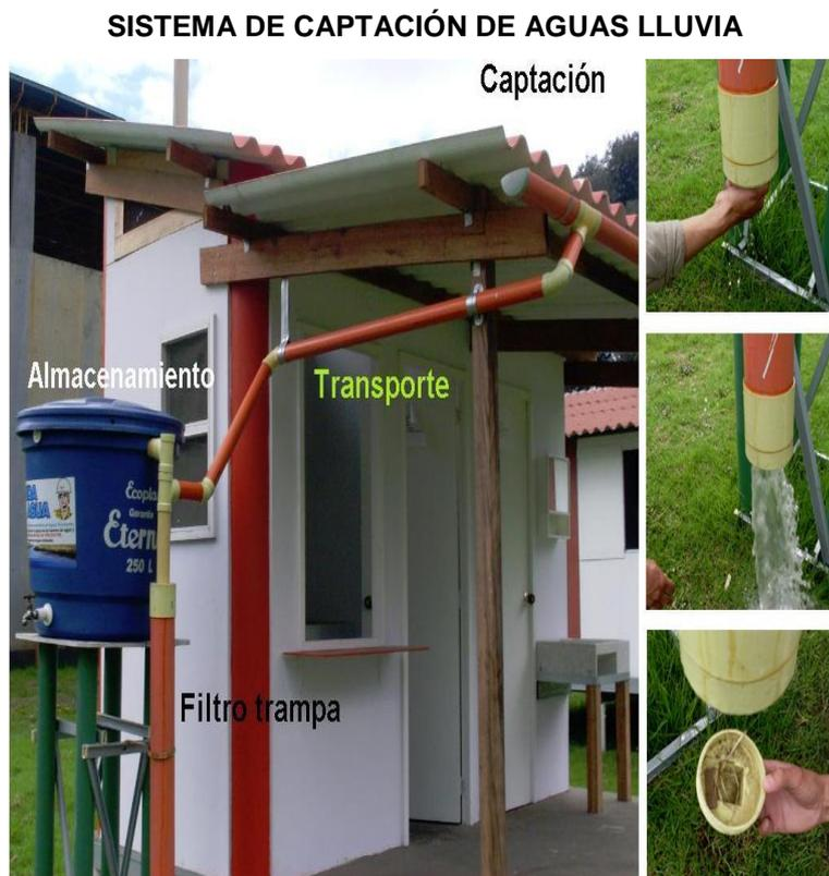
Ilustración 14. Sistema de Captación de Aguas Lluvia.
