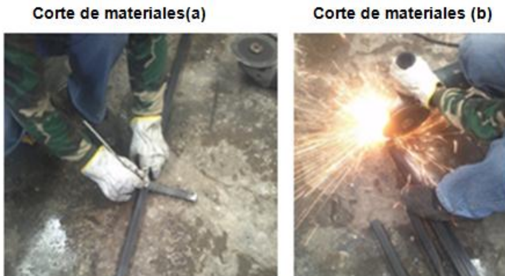
Figura 89 Corte de materiales
