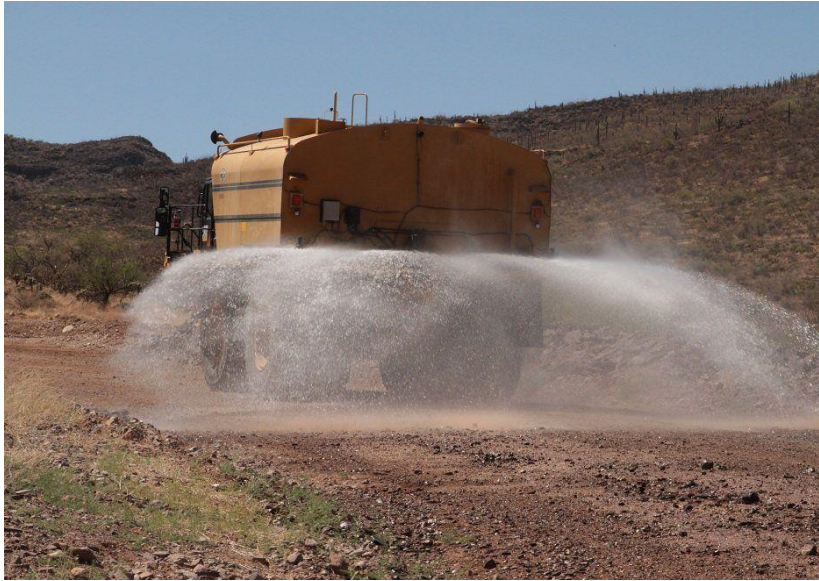
Figura 6: Rociador de tanque después de la aplicación de cal. Fuente: https://lime.org .
