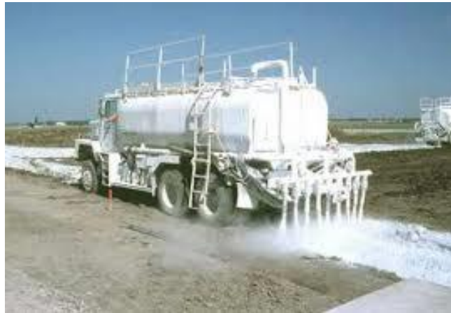
Figura 4: Uso de cal seca con aplicación mecánica. Fuente: https://lime.org
