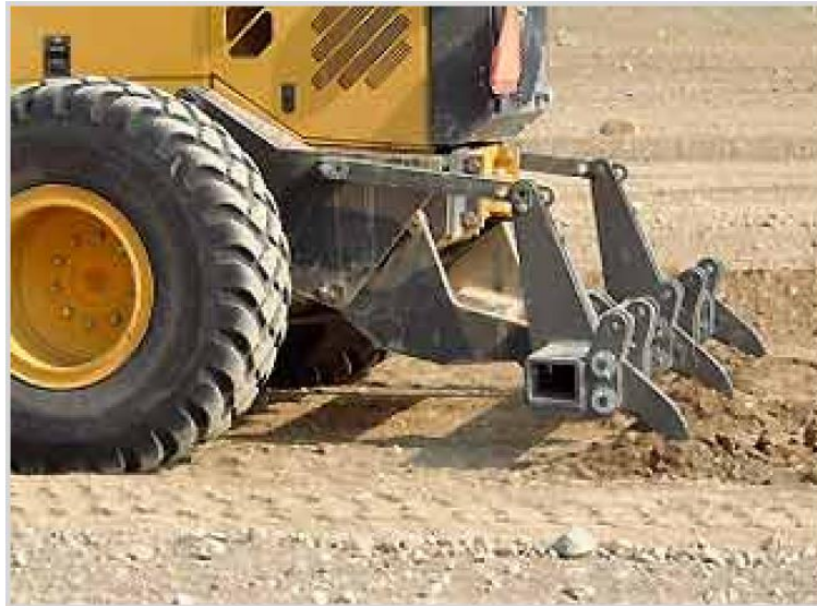
Figura 3: Escarificación y pulverización inicial. Fuente: IIASA CATERPILLAR.
