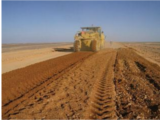
Figura 7: Mezcla y pulverización. Fuente: http://latinamerica.cat.com .
