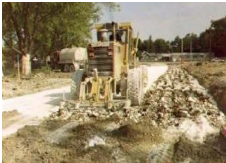
Figura 5: Escarificación después de la aplicación de cal. Fuente: https://lime.org .
