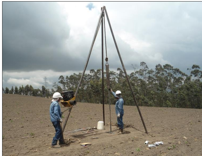
Figura 23.- Ejecución del ensayo de penetración estándar SPT – ZITROCI.
