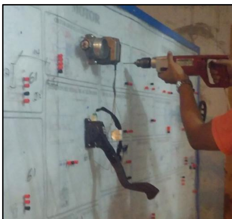
Figura 43. Fabricación de perforaciones en el tablero
