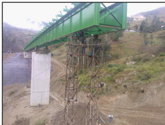
Ilustración 30.- Elevación de obra falsa C
