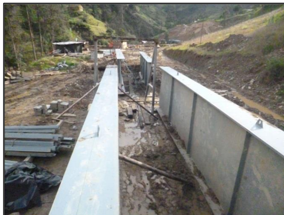
Ilustración 13.- Unión de vigas 3 y 4 FUENTE: Acueducto 1 – Ramal San Antonio AUTOR: Miriam Quilumba
