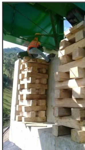
Ilustración 33.- Empolinada sobre la base del estribo A
