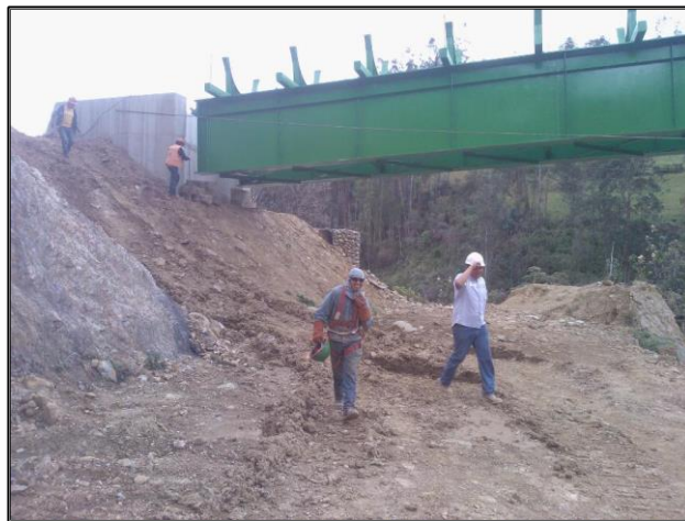
Ilustración 32.- Llegada del acueducto al estribo B
