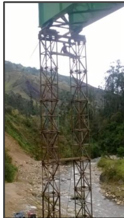
Ilustración 26.- Armado de obra Falsa entre estribo A y central
