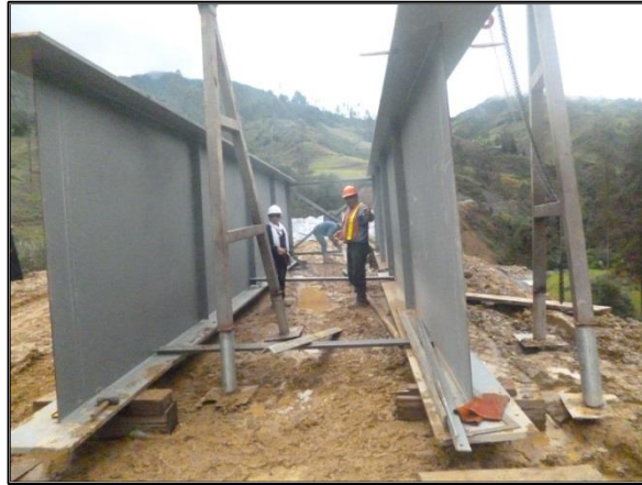
Ilustración 12.- Armado de vigas con pórticos de patio
