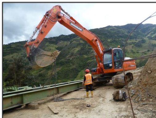
Ilustración 3.- Manipulación de vigas
