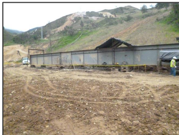
Ilustración 15.- Preparación de vigas para remate (uso de carpas de protección)
