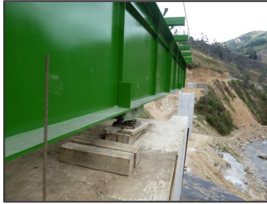
Ilustración 23.- Empleo de varillas (maestras) para alineación del acueducto
