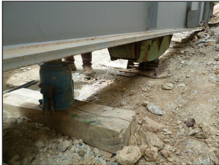
Ilustración 22.- Empleo de rodillos
