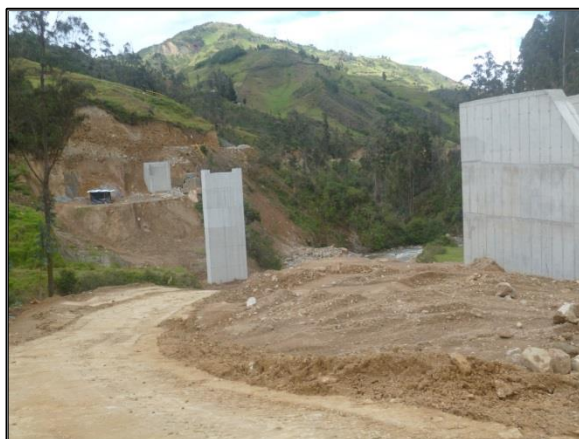
Ilustración 1.- Estribos Acueducto 1 A la derecha estribo A, estribo B lado izquierdo y estribo central AUTOR: Miriam Quilumba
