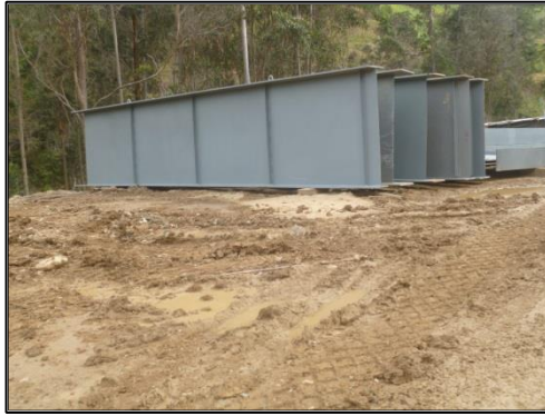
Ilustración 2.- Almacenamiento de vigas
