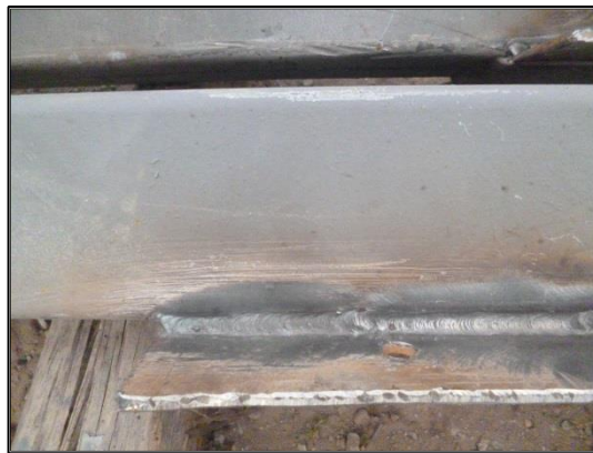
Ilustración 11.- Unión placa - viga - diafragma horizontal
