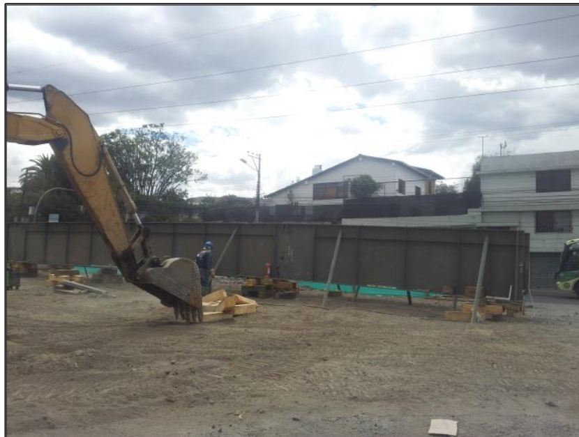
Ilustración 10.- Altura sobre suelo en armado de dovelas FUENTE: Acueducto 1 – Ramal San Antonio AUTOR: Miriam Quilumba
