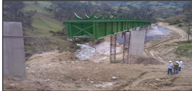
Ilustración 31.- Lanzamiento del tramo final o cuarto tiempo hasta el estribo B
