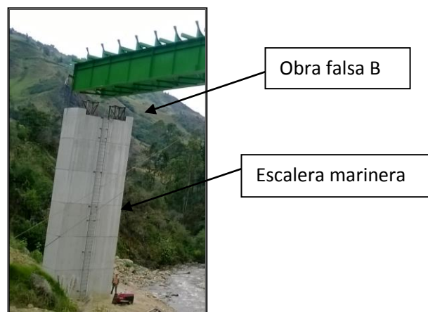
Ilustración 28.- Elevación de escalera marinera para obtener acceso al estribo central
