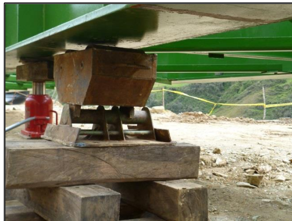
Ilustración 20.- Vista inferior patín inferior - rodillos
