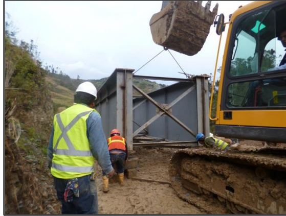
Ilustración 18.- Detalle de direccionamiento con la ayuda de la excavadora
