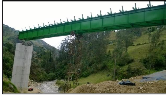
Ilustración 27.- Segundo tiempo de lanzamiento llega hasta estribo central
