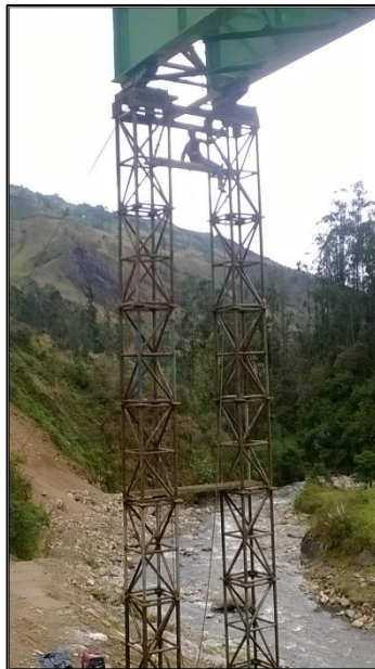
Ilustración 6.- Trabajo que realiza la obra falsa
