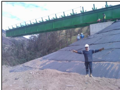
Ilustración 24.- Montaje de los primeros 30 metros
