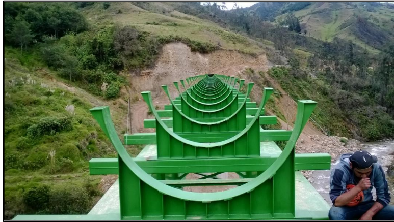
Ilustración 34.- Acueducto 1 posicionado sobre los estribos
