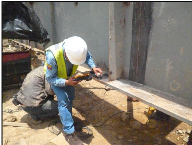
Ilustración 16.- Realización de ultrasonido de Juntas Soldadas
