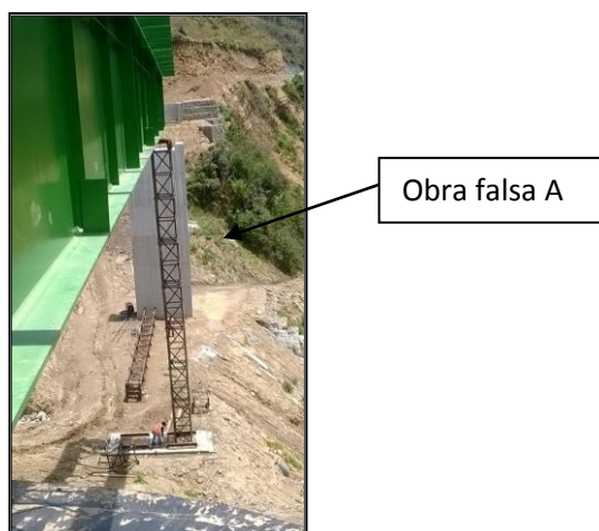
Ilustración 25.- Elevación de obra Falsa
