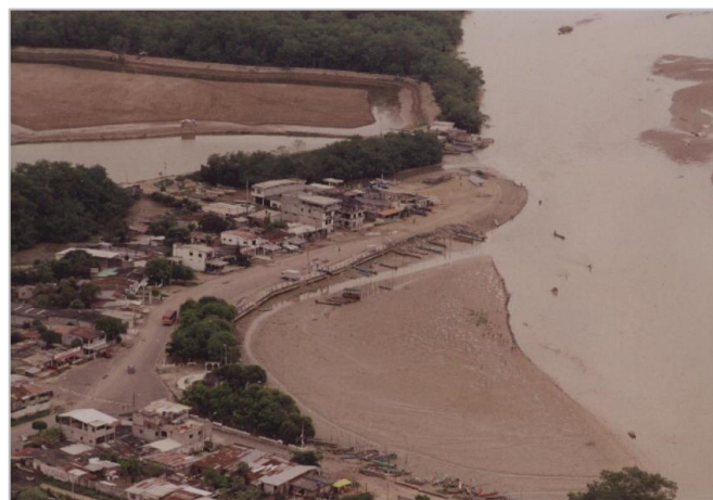
Foto N° 8.- Sedimentación en Dársena Puerto Jeli antes de dragado
