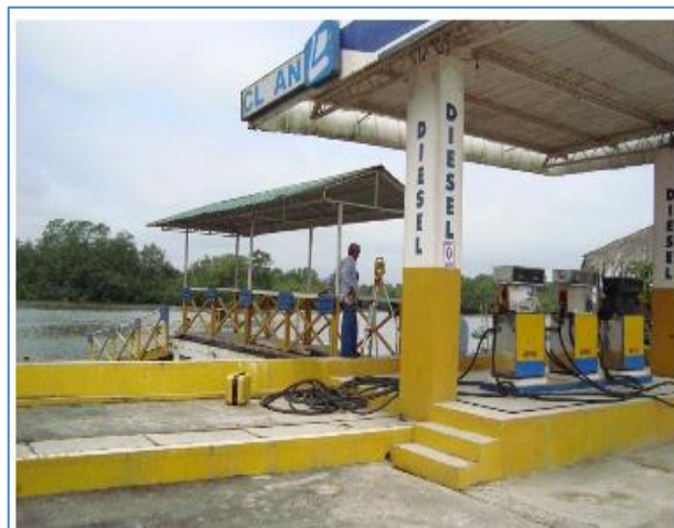
Foto N° 11.- Muelle de Puerto Jelí donde se ubica punto de cota conocida
