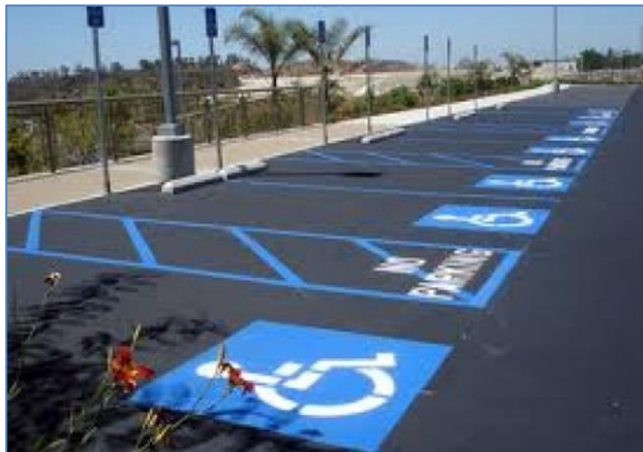
Ilustración N° 15.- Parqueaderos para discapacitados debidamente señalizados.
