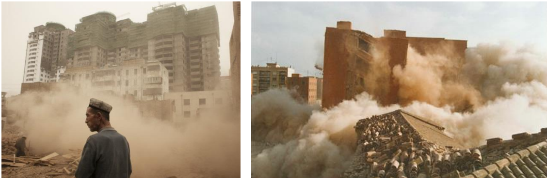
Fig. 10 Implosiones de edificaciones.
