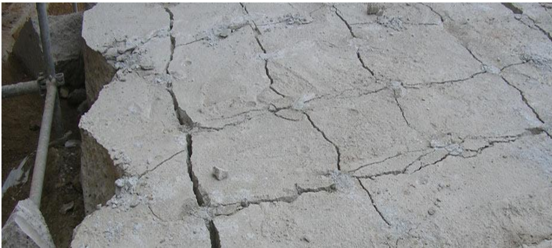
Fig. 7 Corte de hormigón con el agente expansivo.
