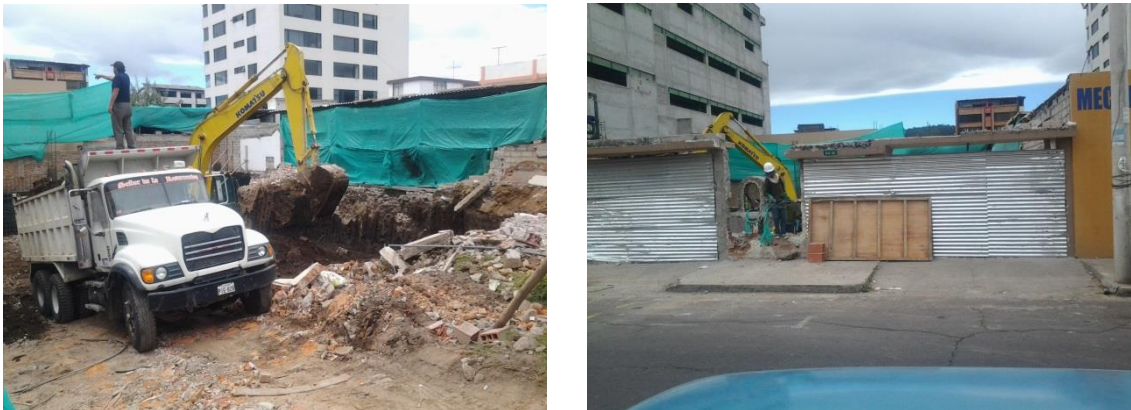
Fig. 24 Desalojo y limpieza final
