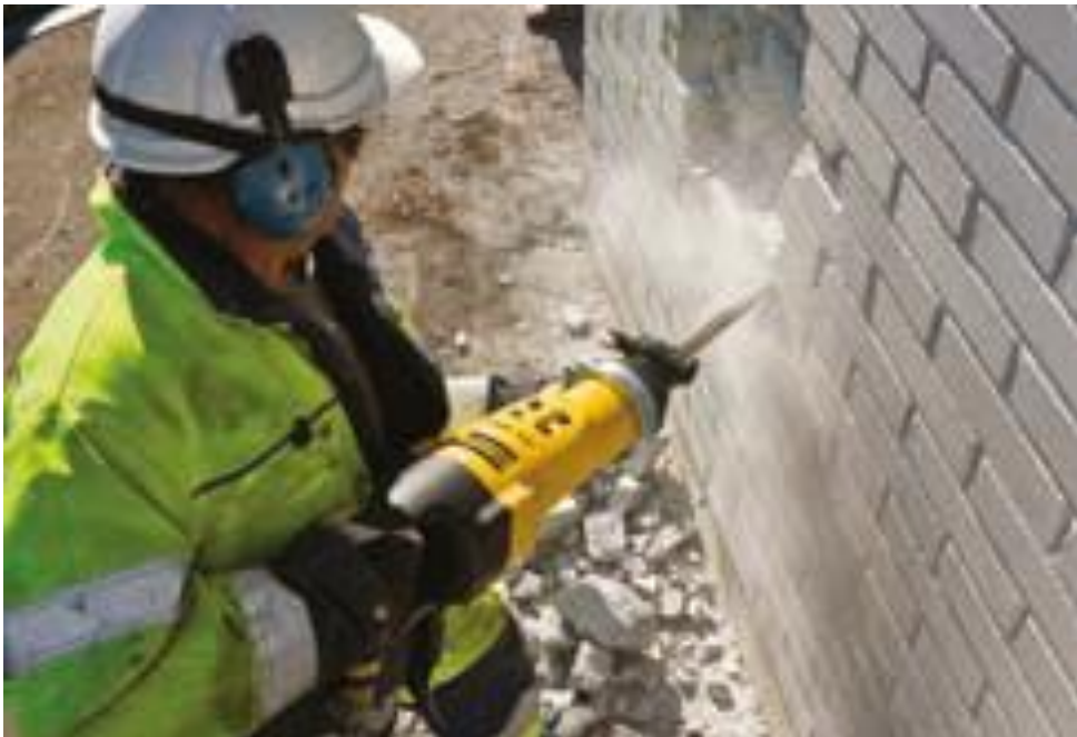
Fig. 3 Equipo de protección y uso de martillo manual de una forma correcta
