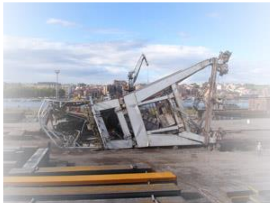
Fig. 12 Explosión para obtener un corte lateral y posterior volcamiento de la estructura
