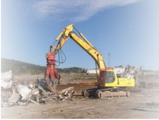
Fig. 13 Desmembramiento de partes de la estructura para su transportación.
