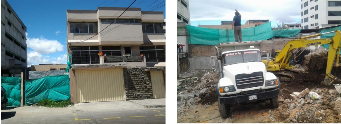
Fig. 23 Casa habitada y demolición
