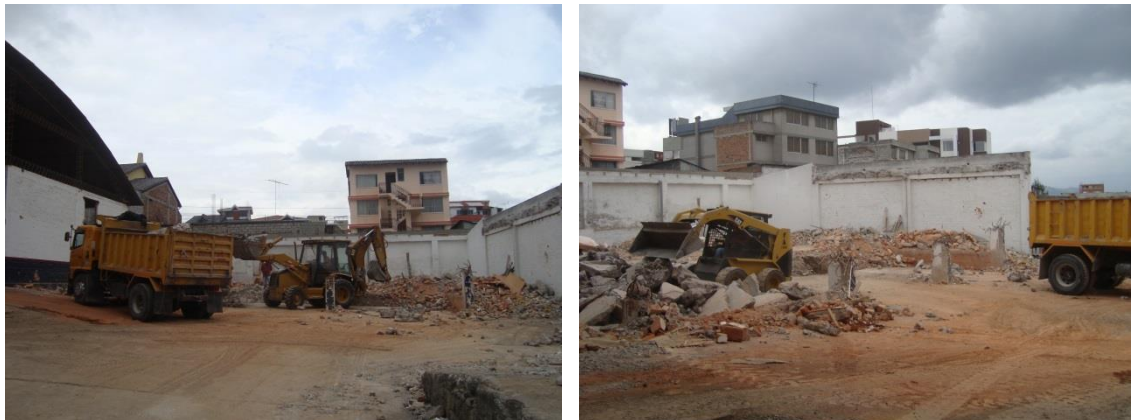
Fig. 21 Acopio, carga y transporte de escombros
