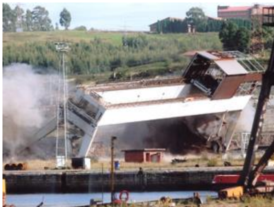
Fig. 12 Explosión para obtener un corte lateral y posterior volcamiento de la estructura
