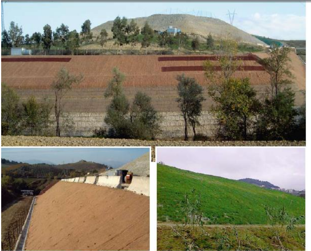
Fotografía 10.- Aplicación de geosintéticos (Geosintéticos Protección contra la Erosión - Bianchini Ingeniero 2009)
