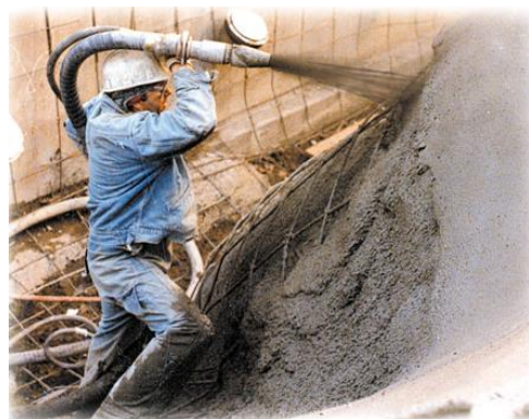
Fotografía 8.- Aplicación de concreto lanzado por vía húmeda (Sistemas para hormigón proyectado – Tecnología y Conceptos 2006)
