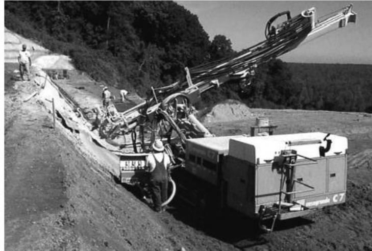
Fotografía 15.- Perforación del talud Soil Nails Walls (Byrne y otros, 1998)
