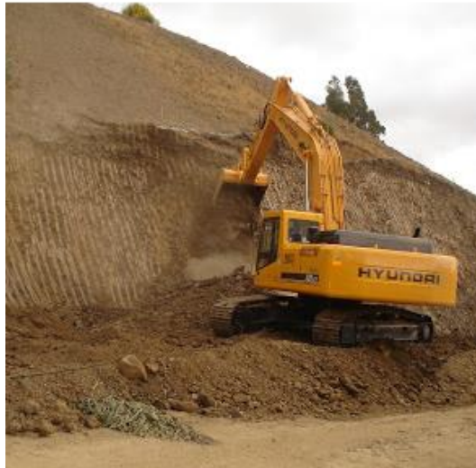
Fotografía 14.- Excavación de taludes Ing. Segundo Mostacero (2008)
