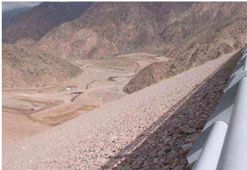
Fotografía 6.- Depósito Artificial – Relleno (Fuente: Panavial S.A.)
