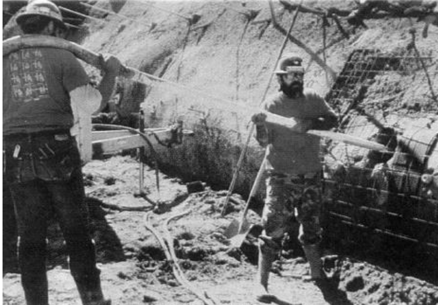
Fotografía 17.- Inyección de mortero Soil Nails Walls (Byrne y otros, 1998)
