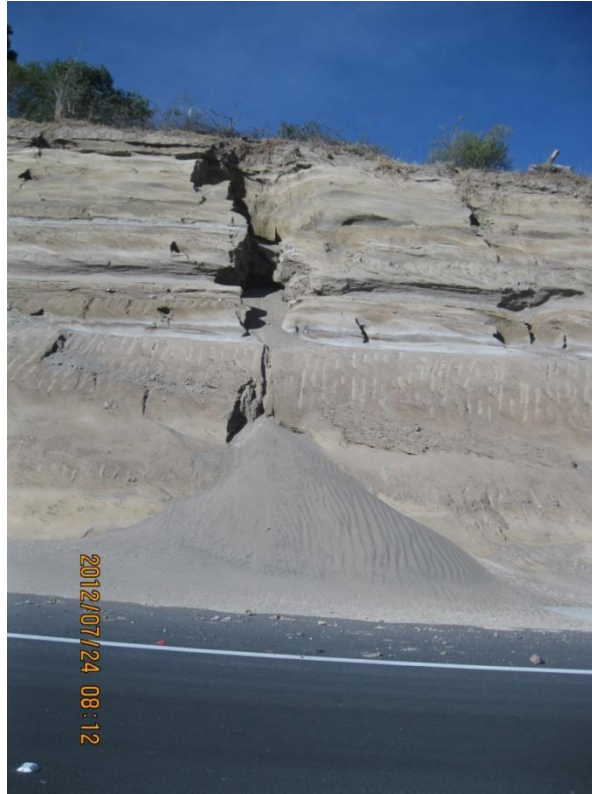
Fotografía 12.- Vista frontal de deslizamiento (Fuente propia)
