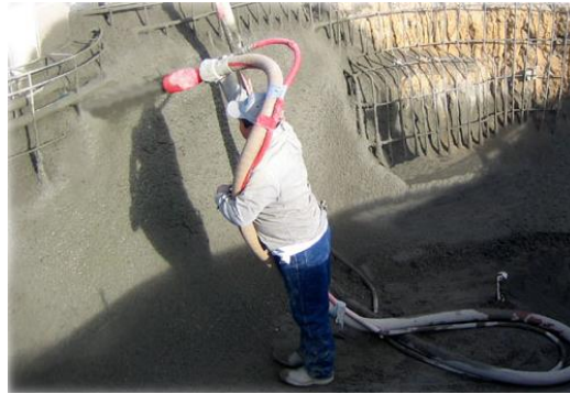
Fotografía 7.- Aplicación de concreto lanzado por vía seca (Sistemas para hormigón proyectado – Tecnología y Conceptos 2006)
