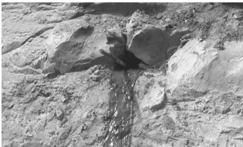
Fotografía 16.- Colocación de anclajes Soil Nails Walls (Byrne y otros, 1998)
