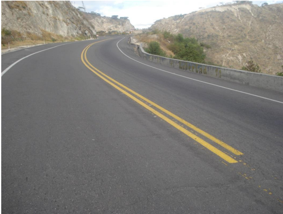
Fotografía No. 5 Obras de drenaje y Sostenimiento (Km 20+800)
