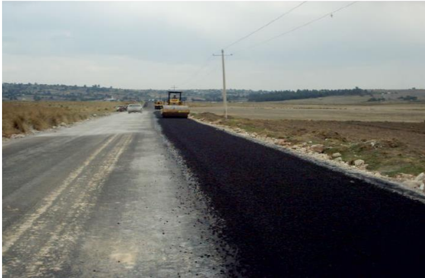
Figura 33. Compactación de sobrecarpeta
