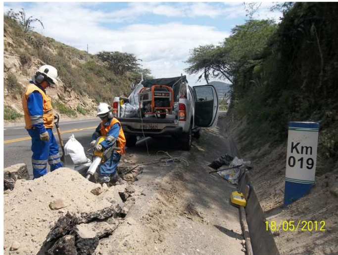
Fotografía No. 16 Ejecución de calicatas
