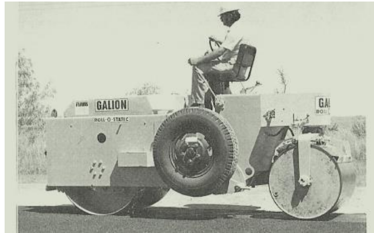
Figura 30. Equipo de Compactación
