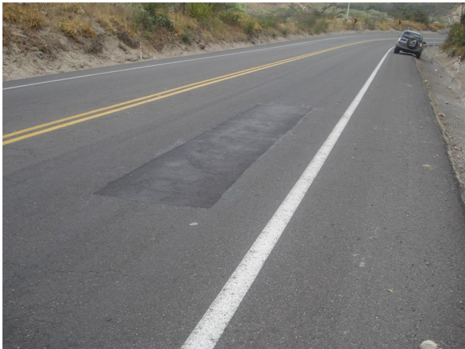
Fotografía No. 6 Mantenimiento realizado (Km 21+000)
