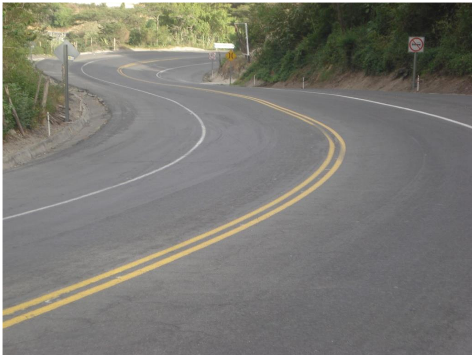
Fotografía No. 4 Señalización horizontal y vertical (Km 21+400)
