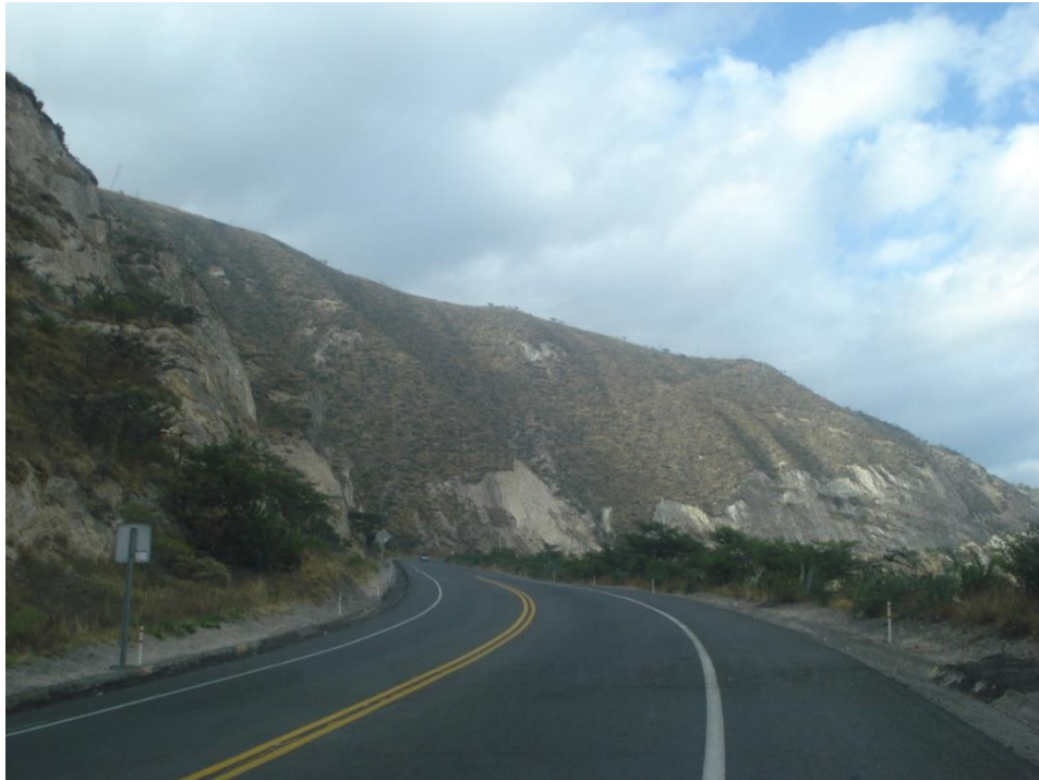
Fotografía No. 3 Sección Típica (Km 20+600)
