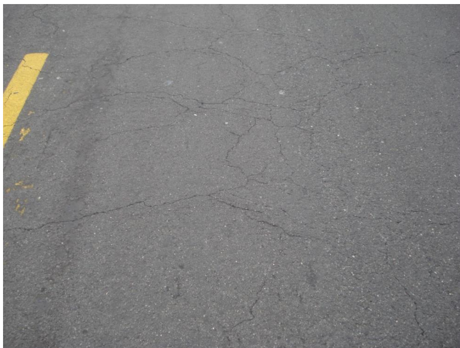
Fotografía No. 8 Fisuración en bloque (Km 20+400)
