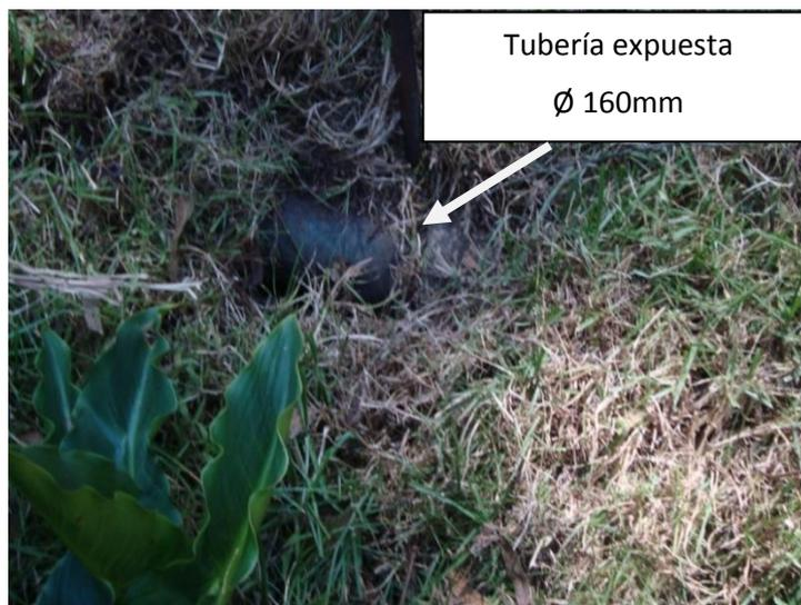
Foto 2. Tubería expuesta a la intemperie
