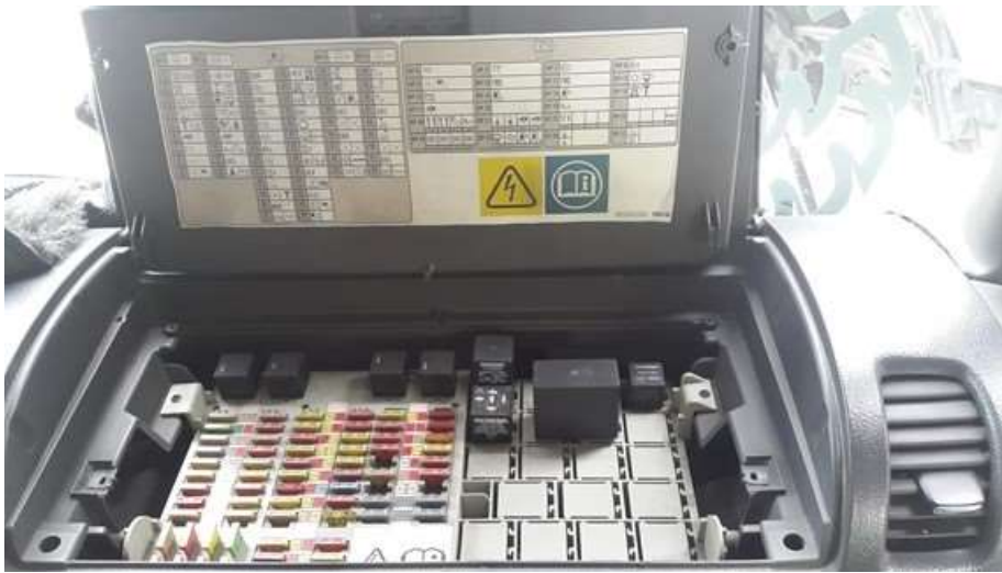
Figura 11 Caja de fusibles y relés.
