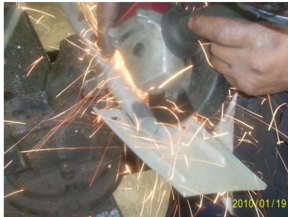
**Gráfico 3.6 Desmontaje de Anclajes**
