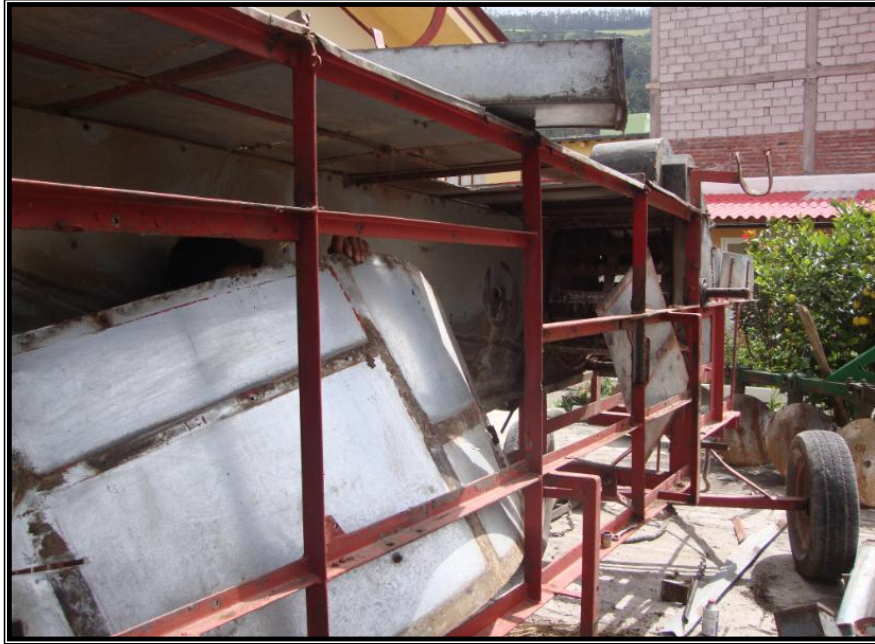
Figura 4.9. Desmontaje de paneles de Tool
