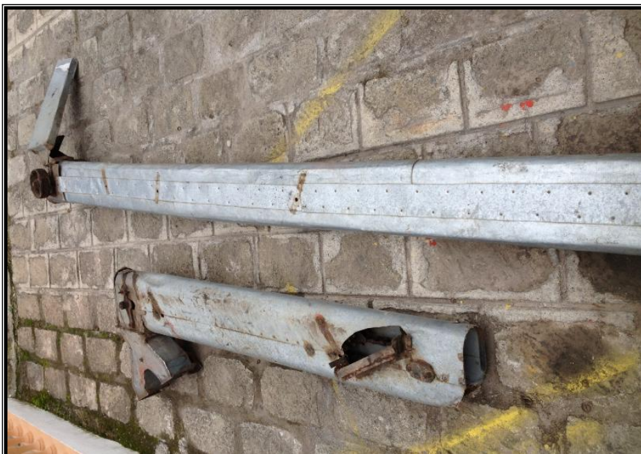
Figura 3.21. Elevadores de cadena tipo túnel
