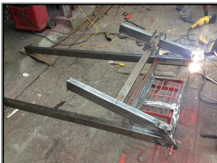
Figura 4.61. Soldadura y unión de mesa con apoyos para motor
