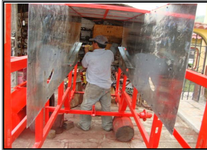
Figura 4.35. Instalación de paneles en tool
