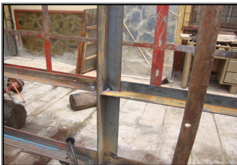
Figura 4.30. Reemplazo de partes afectadas en la Estructura
