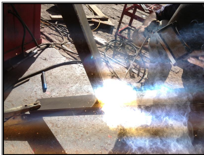
Figura 4.60. Soldadura al arco eléctrico de bastidores y apoyos motor
