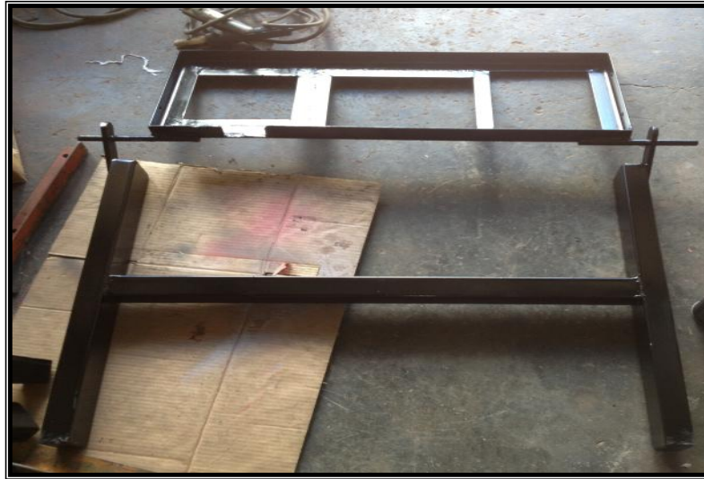
Figura 4.64. Estructura para apoyo del motor
