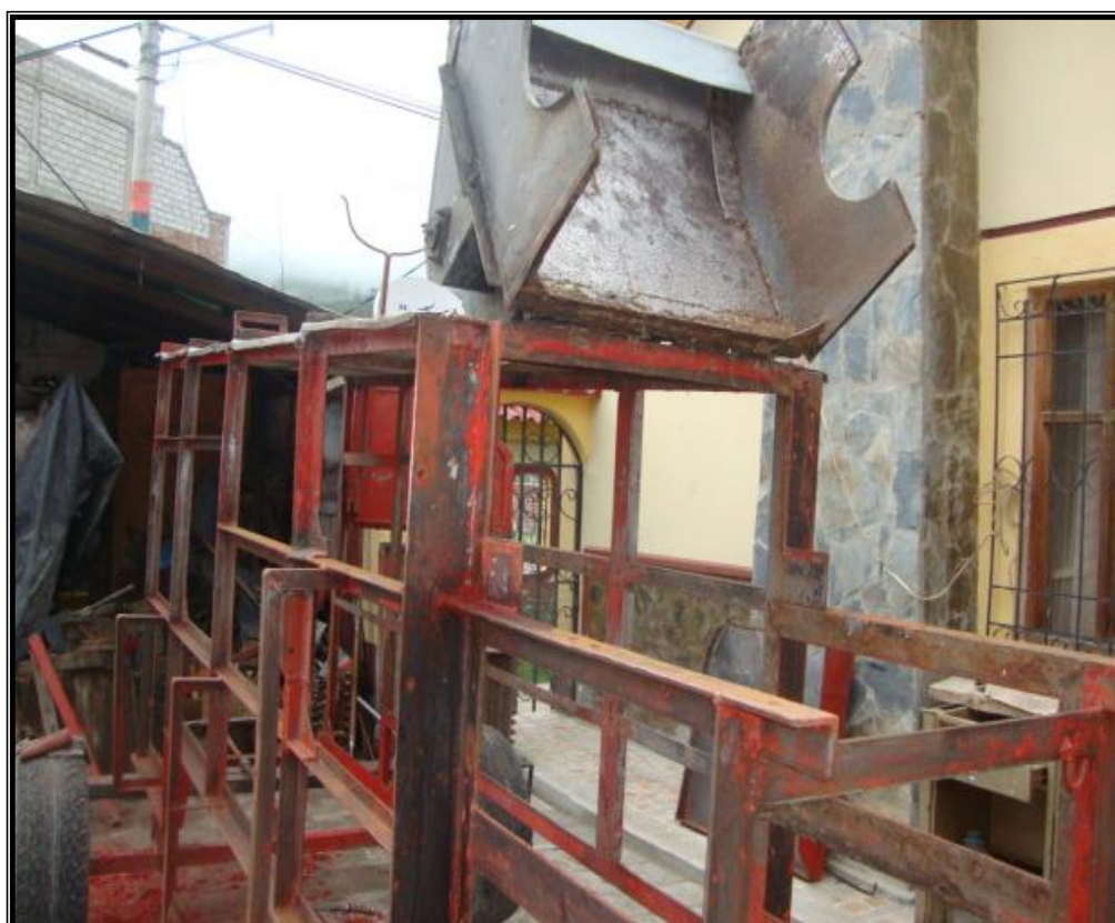
Figura 4.32. Remoción de pintura antigua y lijado
