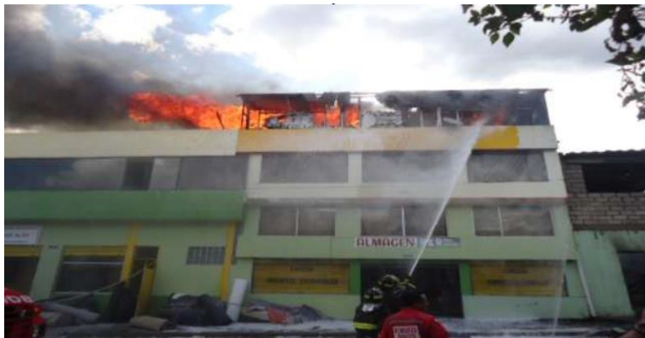
Foto 6 Incendio en almacén de telas.
