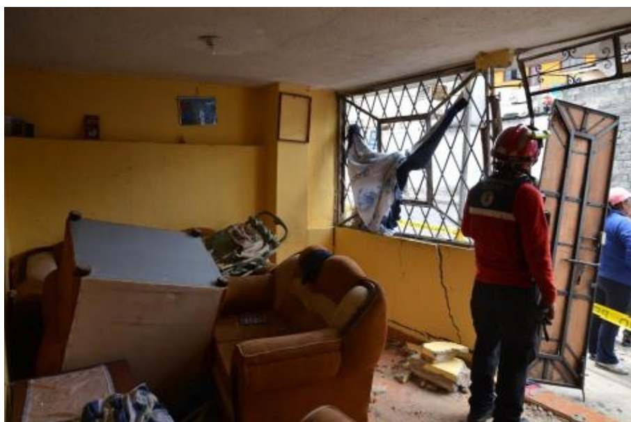
Foto 10 Explosión en vivienda Chahuarquingo 2014
