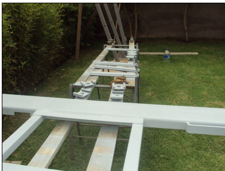
Figura 4.2. Fase previa a pintura
