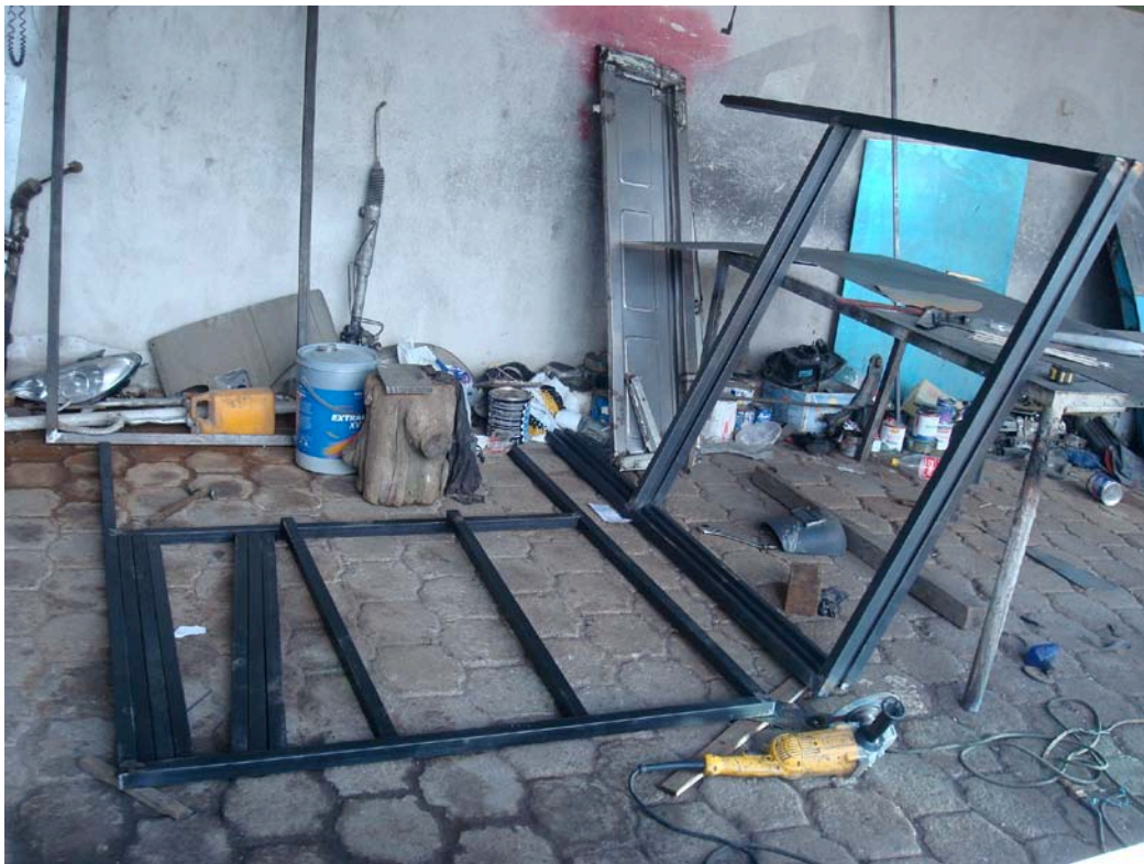
Foto 3.18 Estructura en Proceso de Armado
