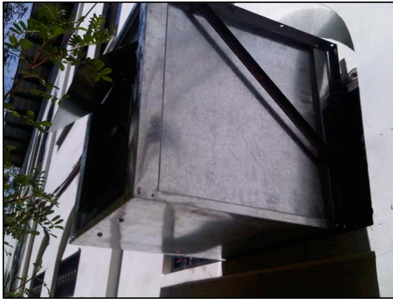
Foto 3.28 Extractor Instalado en Soporte Base
