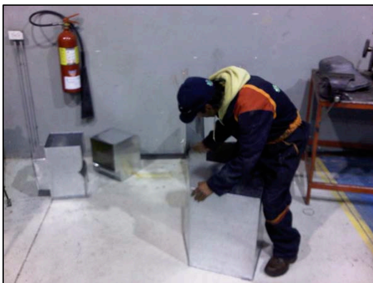
Foto 3.25 Sellado de Ductos
