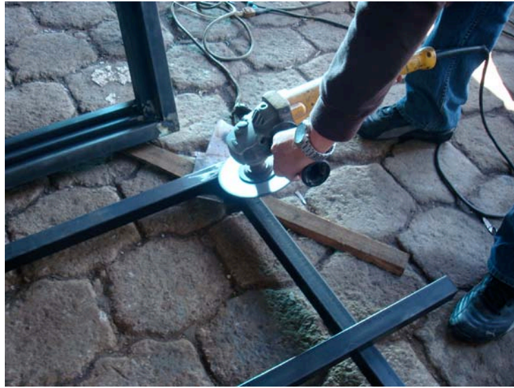
Foto 3.17. Estructura en Proceso de Armado
