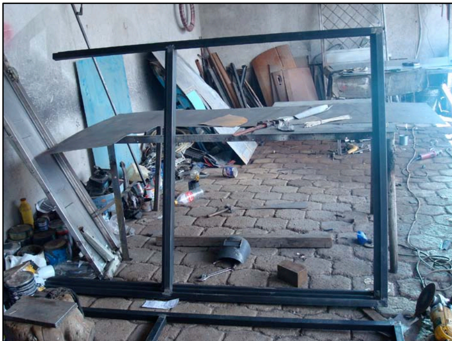
Foto 3.16. Estructura en Proceso de Armado
