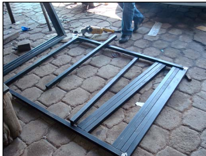
Foto 3.14 Estructura en Proceso de Armado
