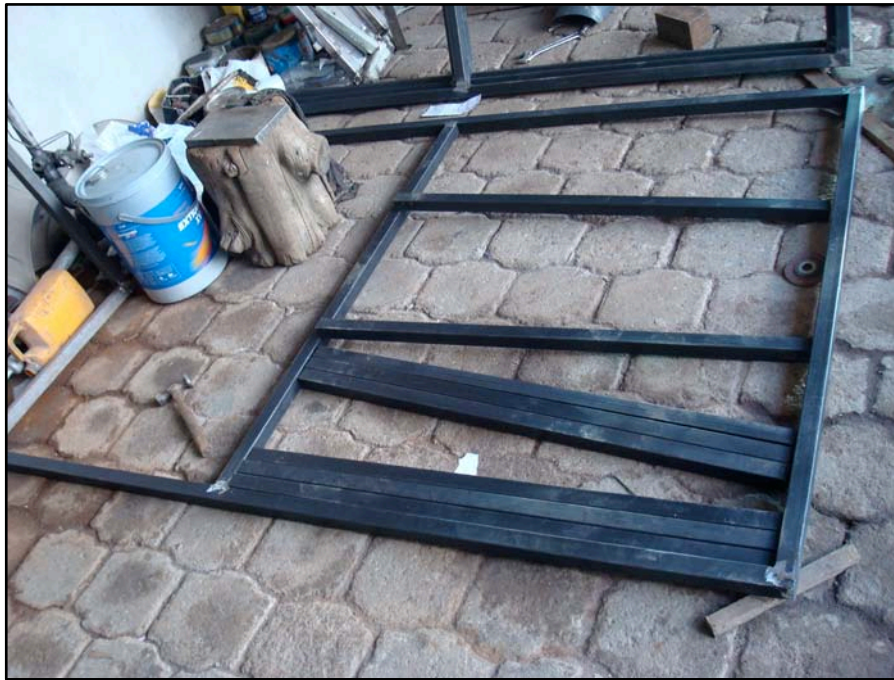
Foto 3.15 Estructura en Proceso de Armado
