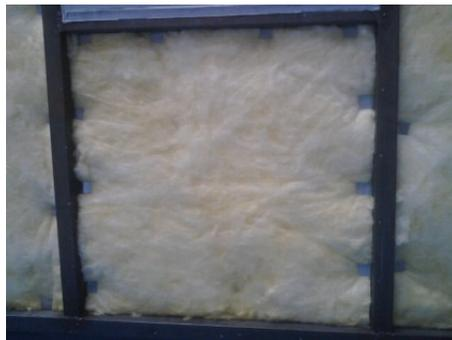
Figura 3.12. Sección de la cabina recubierta con lana de fibra
