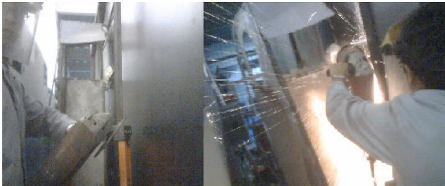
Figura 3.5. Extracción con amoladora
