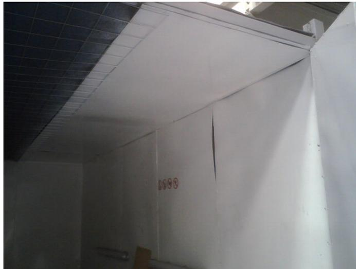
Figura 3.27. Cabina original de pintura sin ángulos laterales de techo
