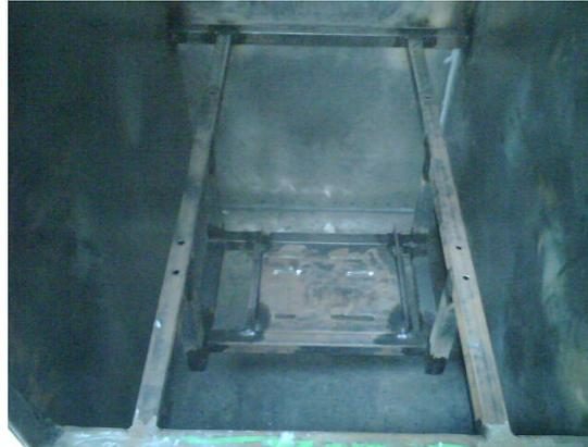
Figura 3.39. Bases dentro del ducto montadas
