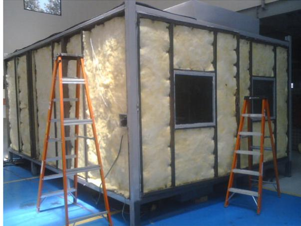
Figura 3.15. Cabina recubierta en su totalidad con lana
