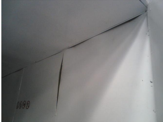
Figura 3.24. Deformaciones internas de la cabina
