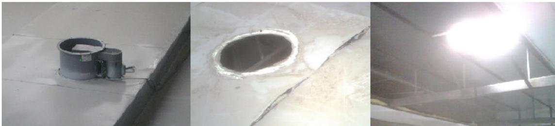
Figura 3.11. Extracción ventilador del ducto de admisión
