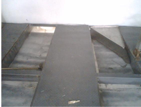
Figura 3.21. Modificación de ducto en la parte de extracción en la parte posterior
