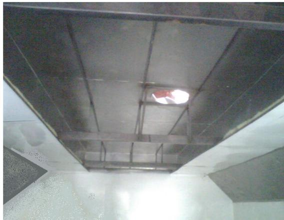
Figura 3.8. Extracción del enrejado y filtro de admisión 2
