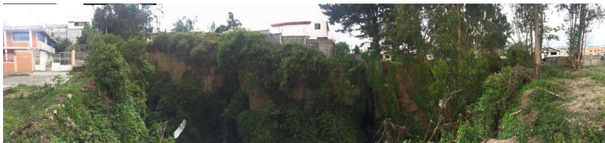
Foto 17: Quebrada Chusig. Autor: Javier Donoso.
