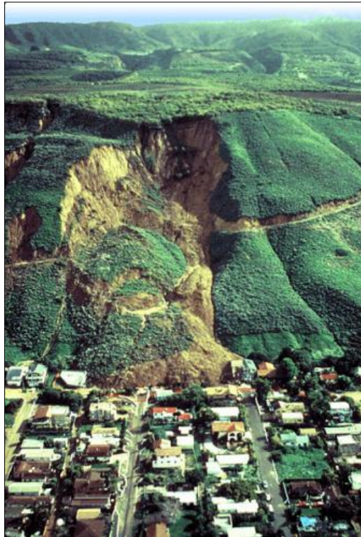
Fotografía 1: Deslizamiento de tierra sobre las viviendas Autor: (Shuster, 1995).
