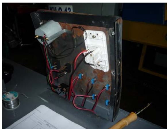
Figura 4.26 Apreciación posterior del panel de control.
