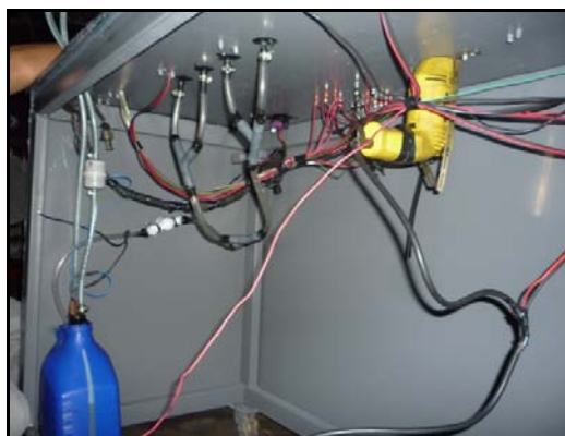
Figura 4.22 Apreciación de la parte baja del tablero.
