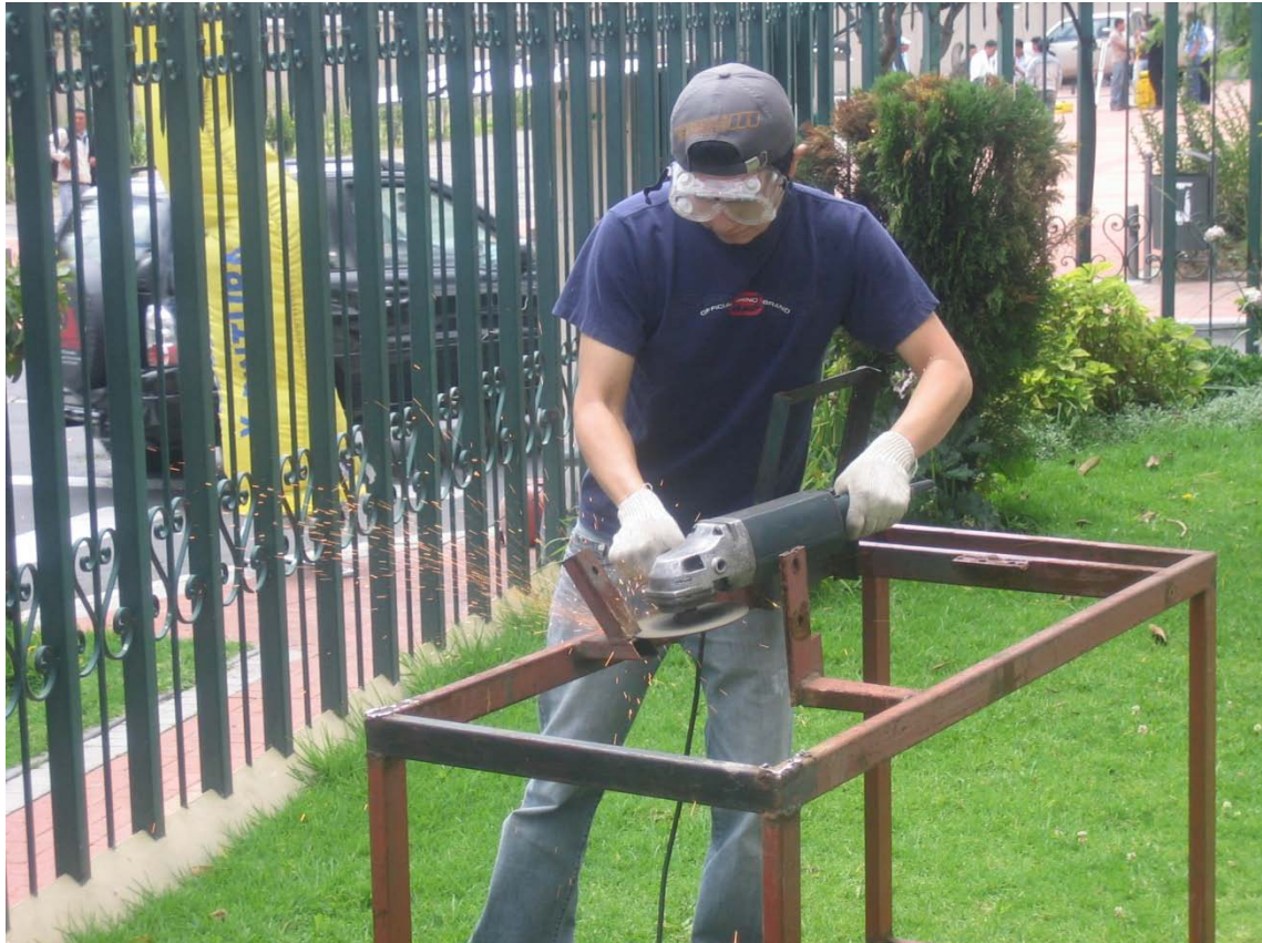
Figura 4.3 Cortando la estructura.
