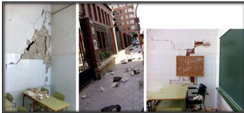
Imágenes reales de aulas y la fachada de un colegio Tras los terremotos de Lorca
