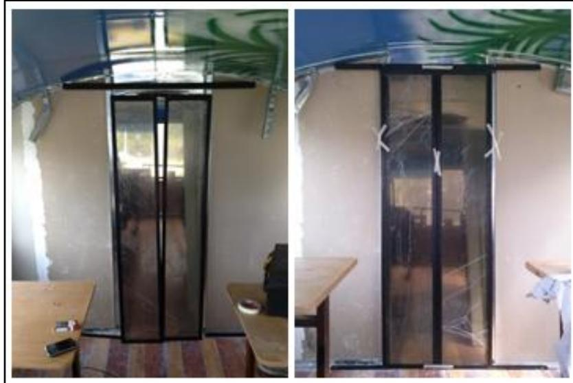
Figura 3.75 Instalación de sistema de puertas corredizas.
