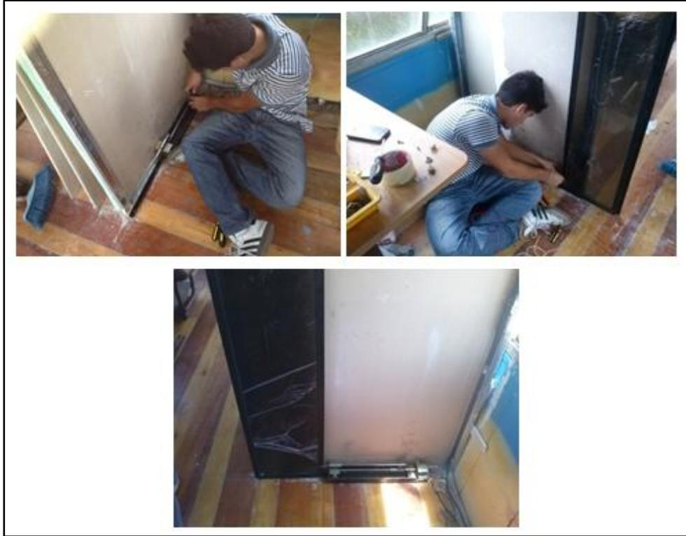
Figura 3.76 Instalación de mecanismo de apertura/cierre de puertas.
