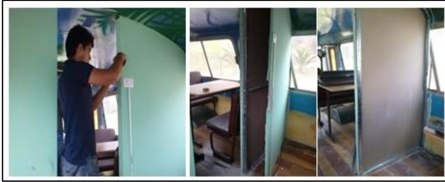
Figura 3.73 Desmontaje de división interior deteriorada
