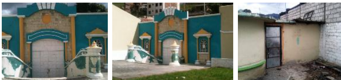
Ilustración 1. Estado actual del balneario de aguas sulfurosas
