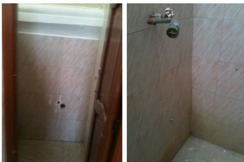
Ilustración 62. Duchas en el equipamiento del balneario de aguas sulfurosas
